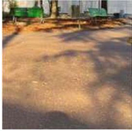
CALCESTRUZZO ARCHITETTONICO | Pavimentazione carrabile
