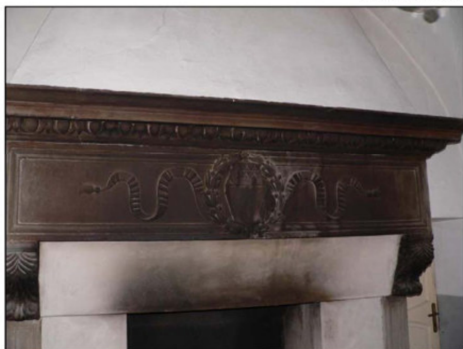
FOTO N.4 Particolare del camino del XV secolo con stemma nobiliare
