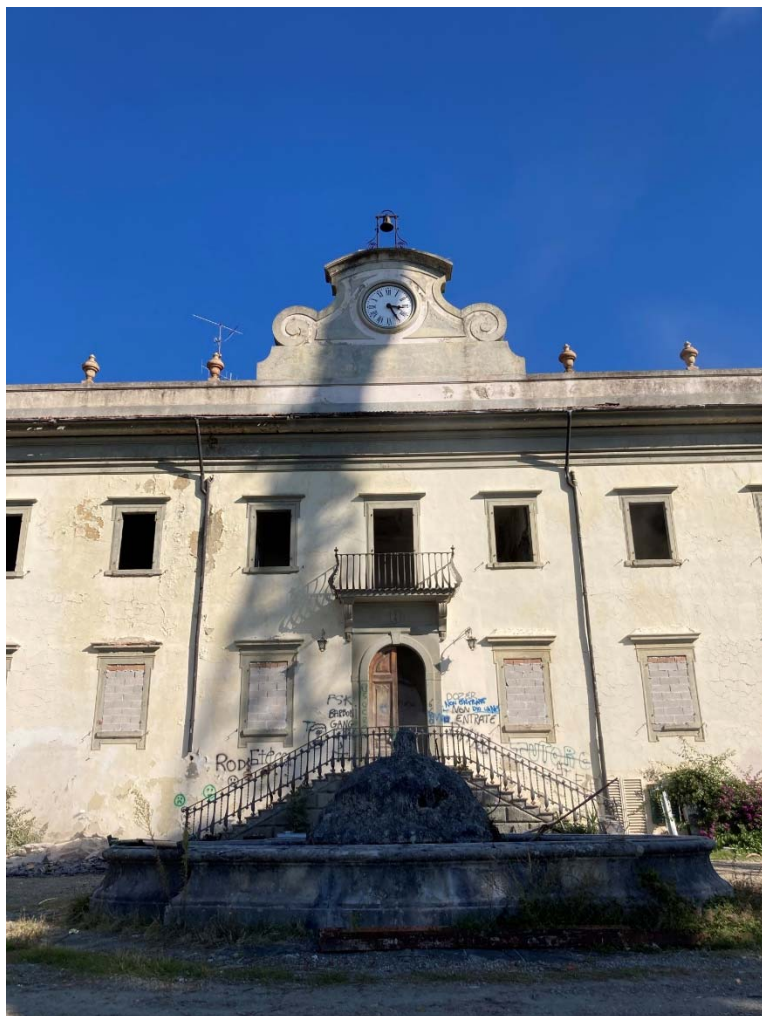
Vista 01 facciata principale della VILLA
