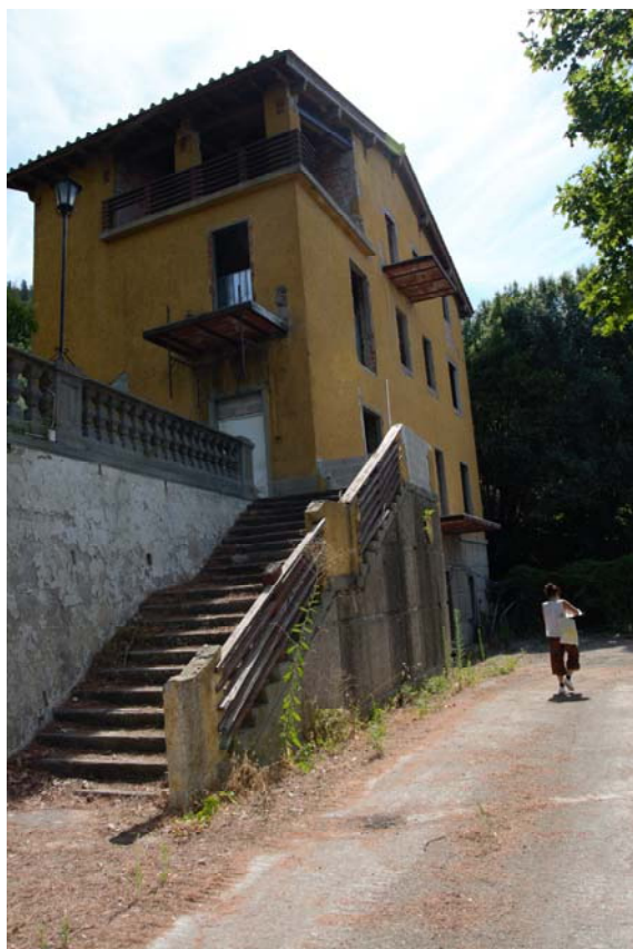
Vista 14 Edificio C – Depandance
