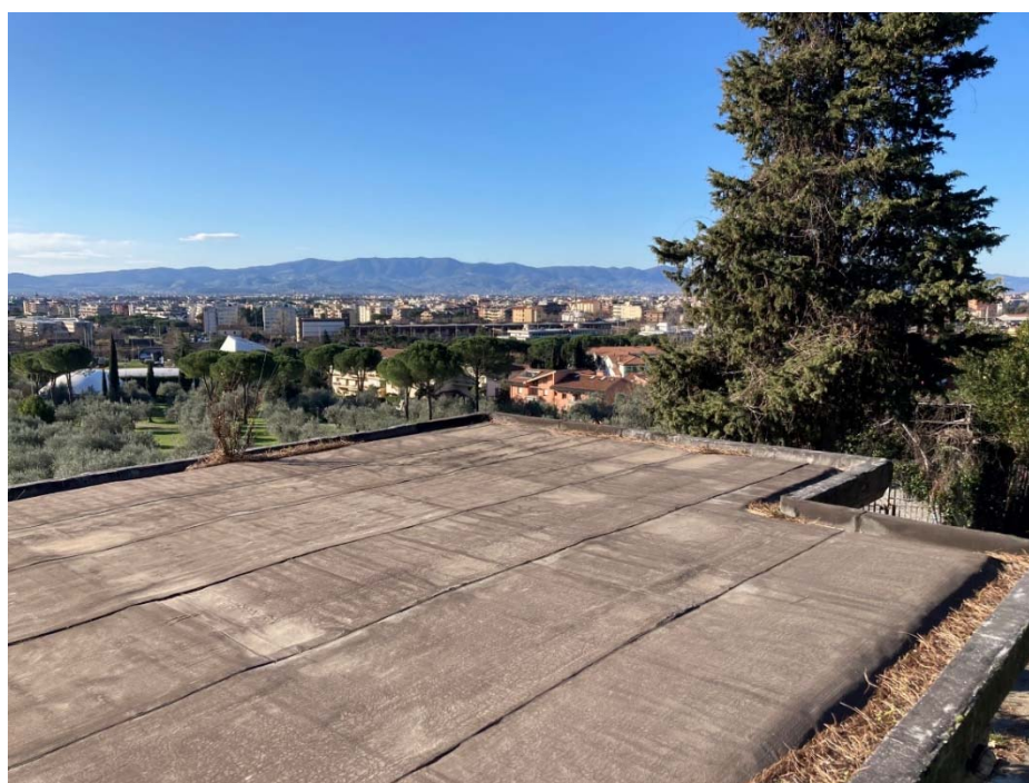
Vista 30 - Casa del Casiere vista della copertura
