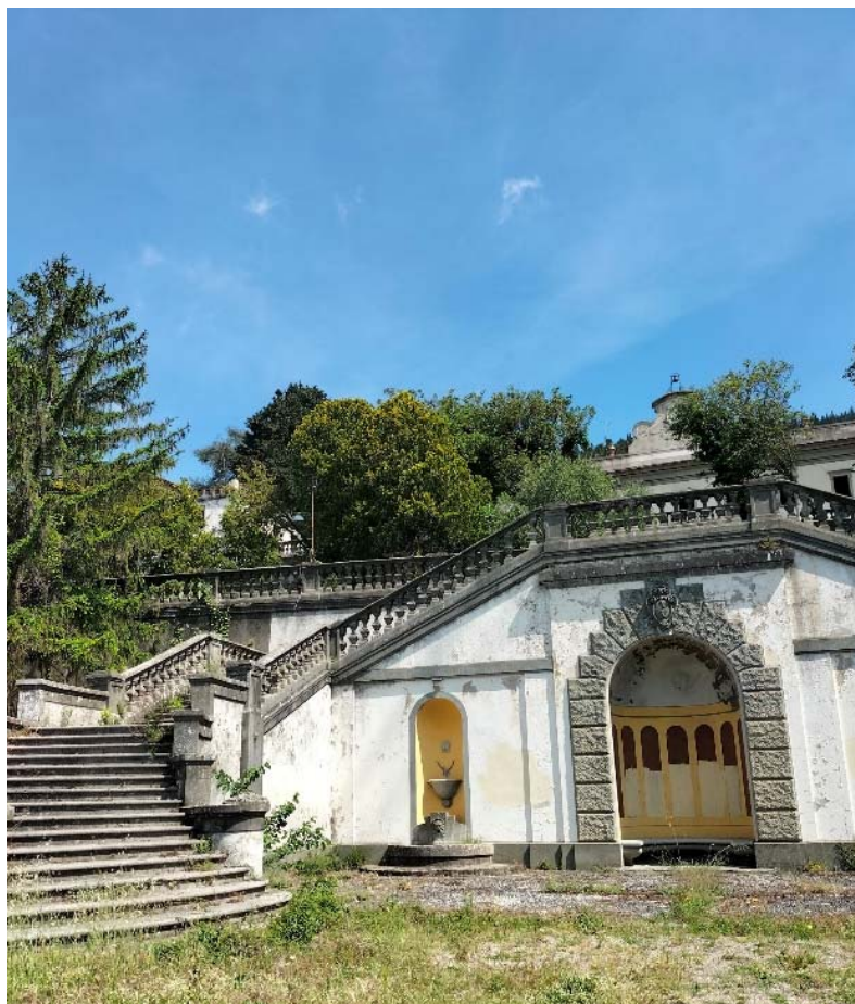
Vista 22- scalone a "tenaglia" di ingresso
