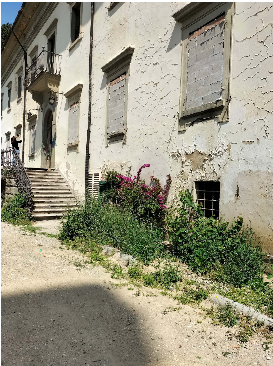
Vista 11 - vista ingresso principale della Villa
