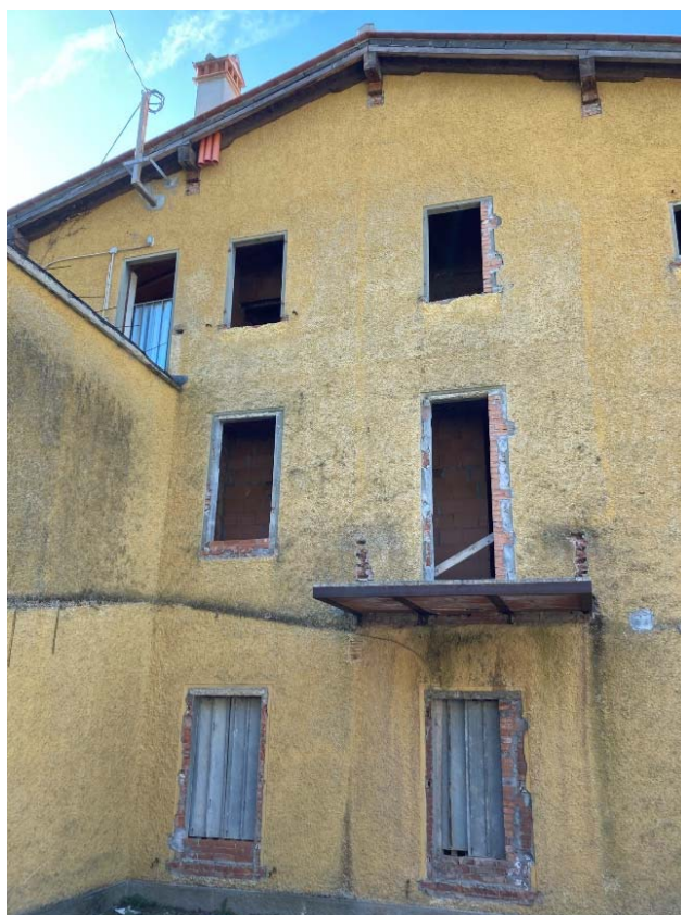
Vista 15 Edificio C – Depandance prospetto tergale
