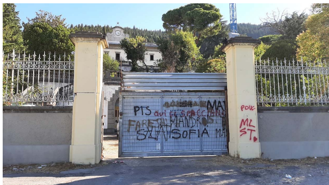
Vista 32 – ingresso principale da Via per Poggio Secco
