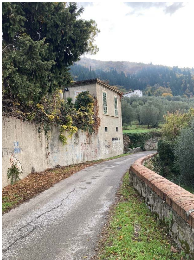
Vista 29 - Casa del Casiere, prospetto su Via per Il Poggio Secco
