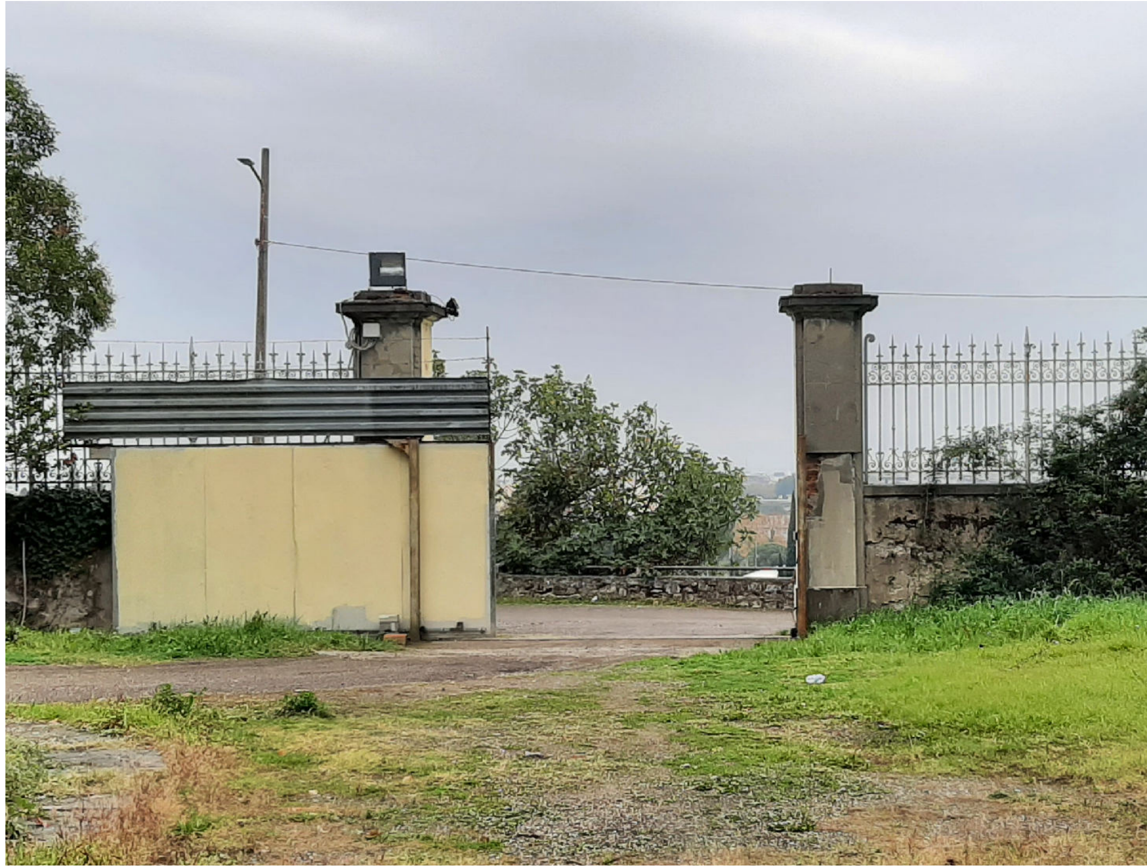
CANCELLO DI INGRESSO PRINCIPALE vista attuale dall'interno
