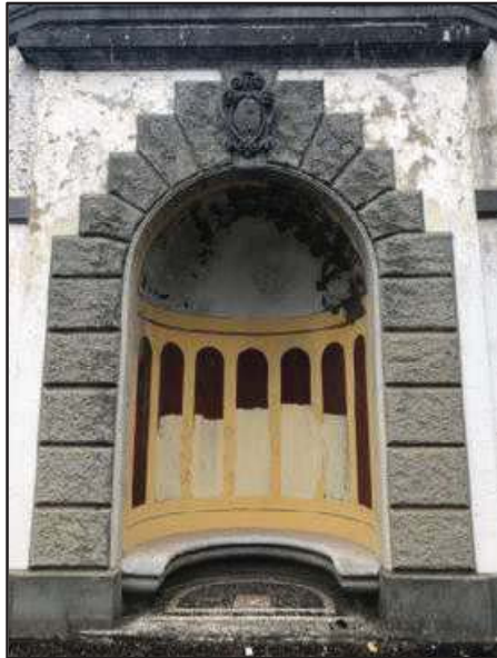
Particolare intonaci delle nicchie presenti nella piazzetta dello scalone a tanaglia.
