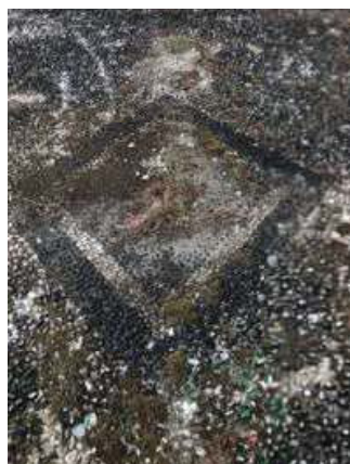
Particole del parapetto dello scalone realizzato a cemento
