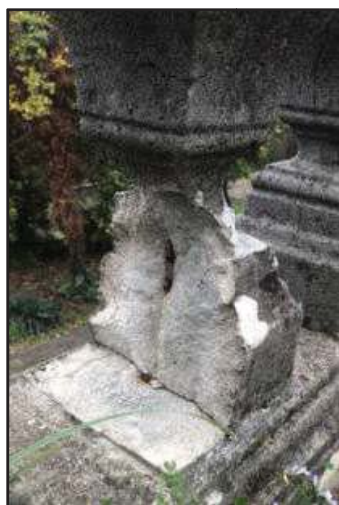
Particole del parapetto dello scalone realizzato a cemento
