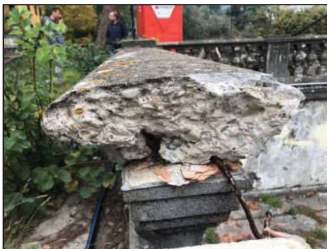
Particole del parapetto dello scalone realizzato a cemento
