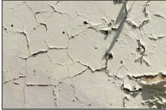
Caratteristiche del degrado superficiale della verniciatura dell'intonaco.
