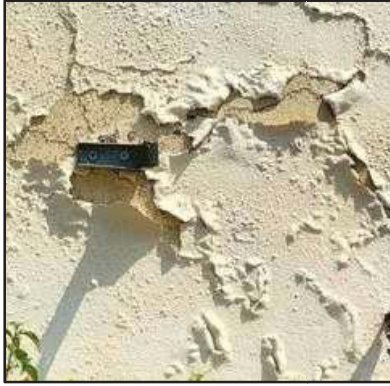
Caratteristiche del degrado superficiale della verniciatura dell'intonaco.
