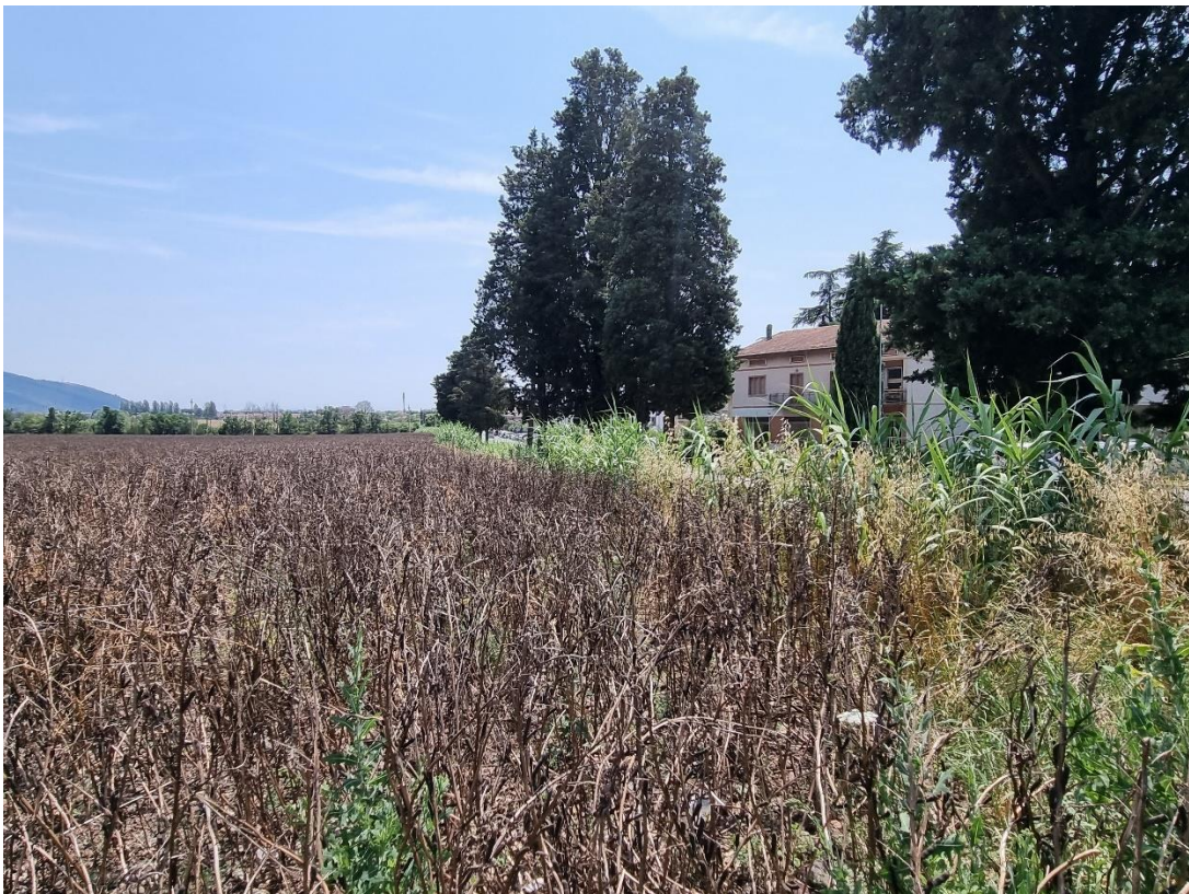
Figura 3 – Sinistra idraulica del Fosso Ficarello da cui si nota la presenza di coltivazioni fino al ciglio di sponda e l'assenza di una pista manutentiva
