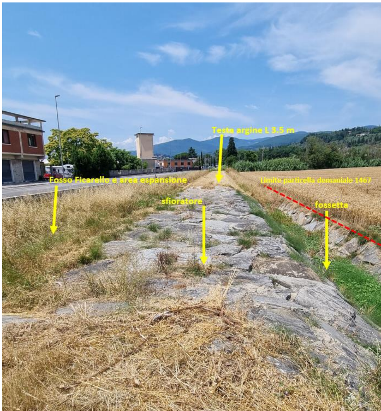
Figura 5 – Vista verso monte
