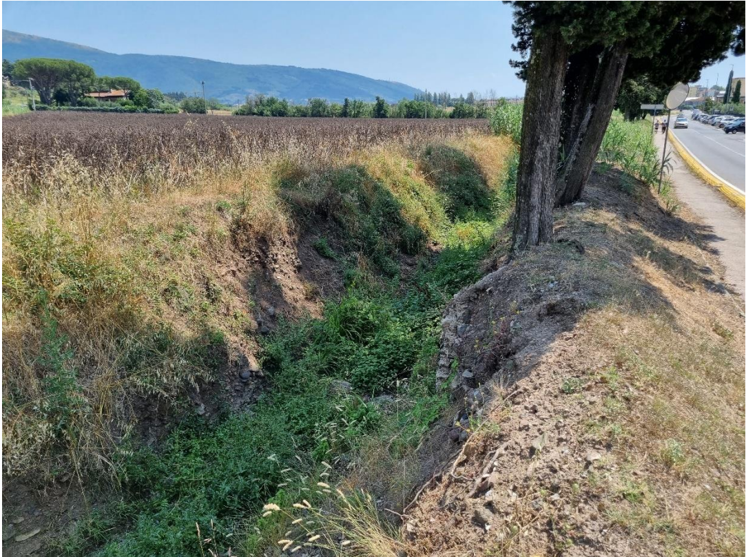
Figura 2 - Fosso Ficarello a valle dello sbocco dalla rotatoria di Via Galceti
