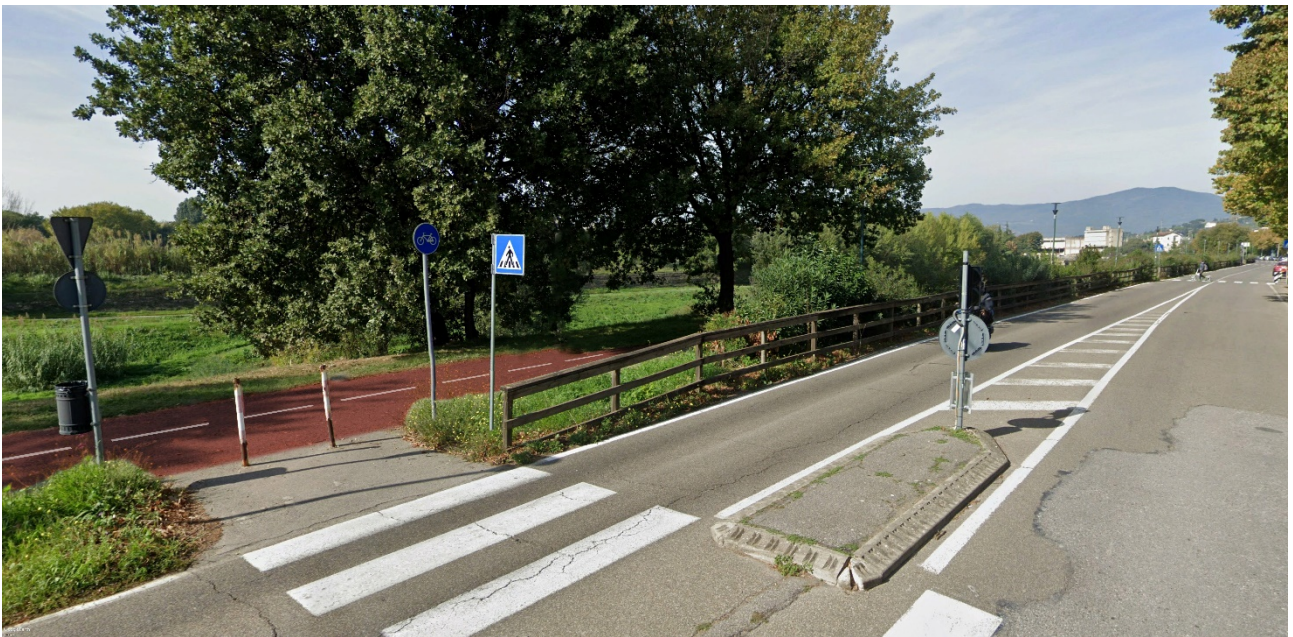
Viale Alcide De Gasperi, Prato – stato modificato con allargamento pista esistente verso il F. Bisenzio, riqualificazione fondo e segnaletica orizzontale nonché ricollocazione cartellonistica stradale verticale
