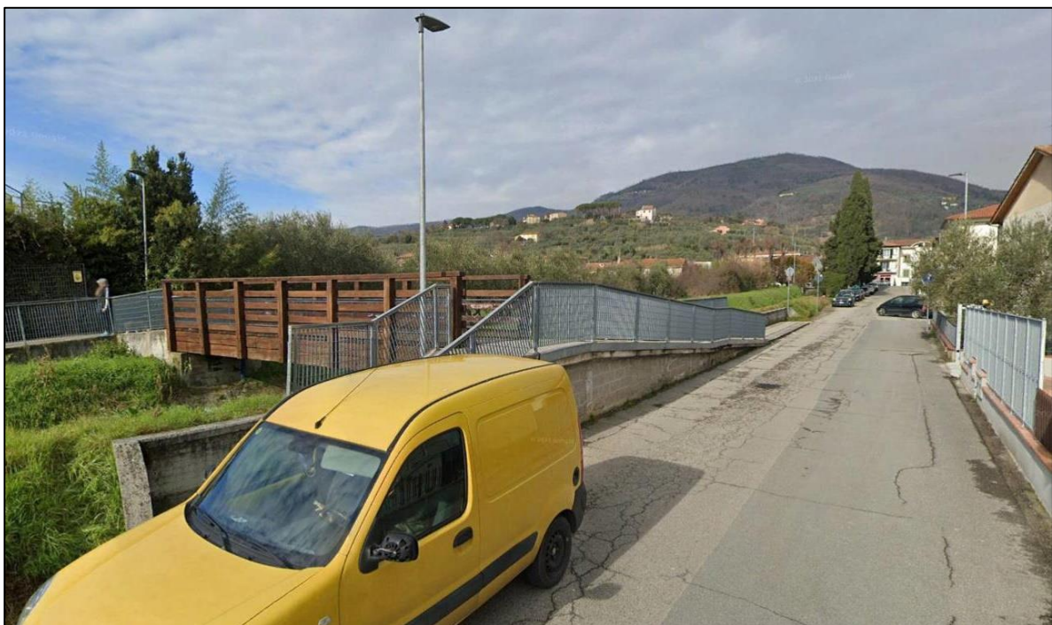
Figura 50 - Attraversamento da sostituire su T. Settola (Montale)
