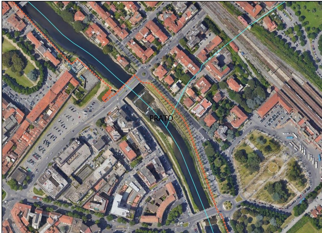
Figura 86 –Ciclovía in corrispondenza di ponte XX Settembre
