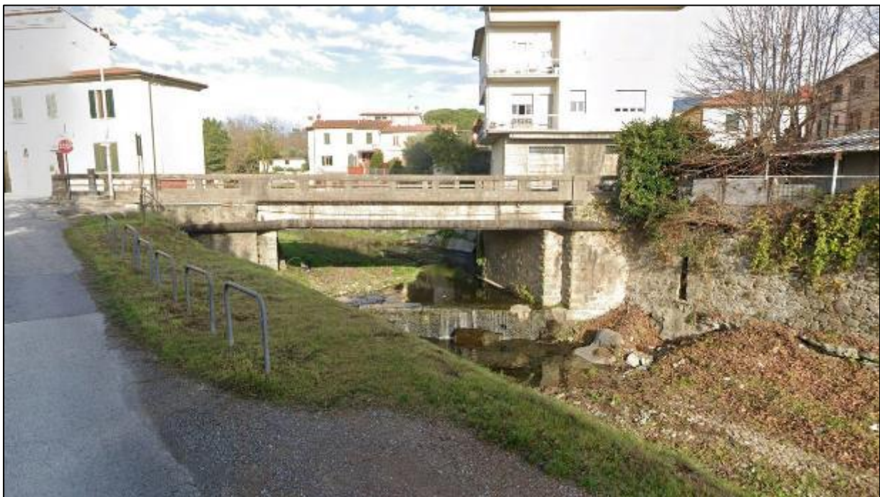
Figura 29 – Attraversamento esistente sul Torrente Bure
