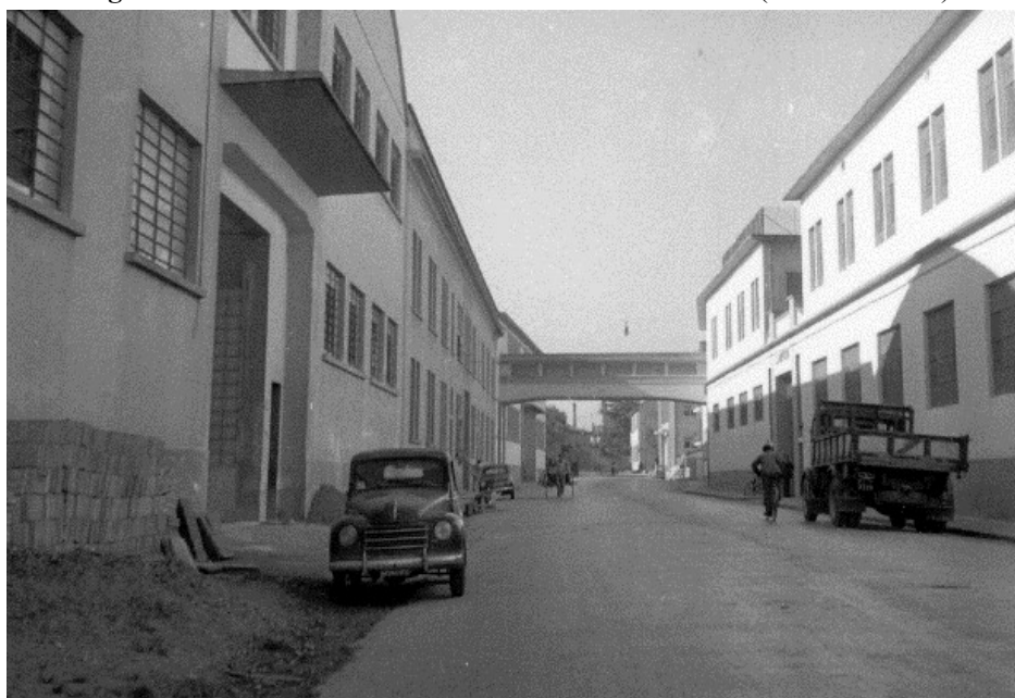
Figura 18. Fabbrica Sbraci Vasco con passerella di collegamento dei due stabilimenti (Archivio Ranfagni)
