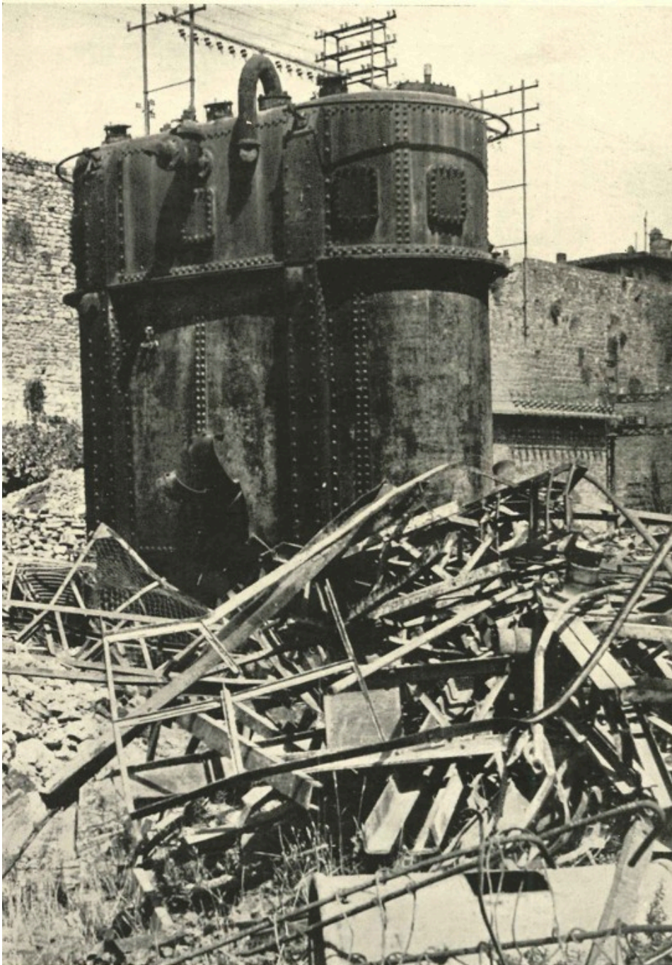
Fig.24. Il trasformatore della sottostazione principale della SELT Valdarno in Via Arcivescovo Martini sabotato dai tedeschi (Tamburini, 1945).
