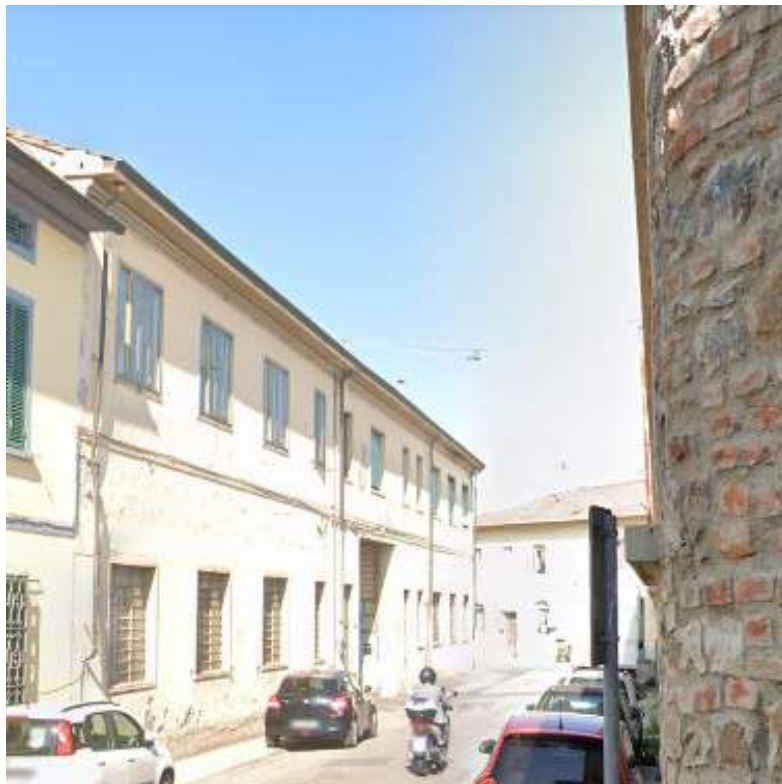
Fabbrica via San Paolo
