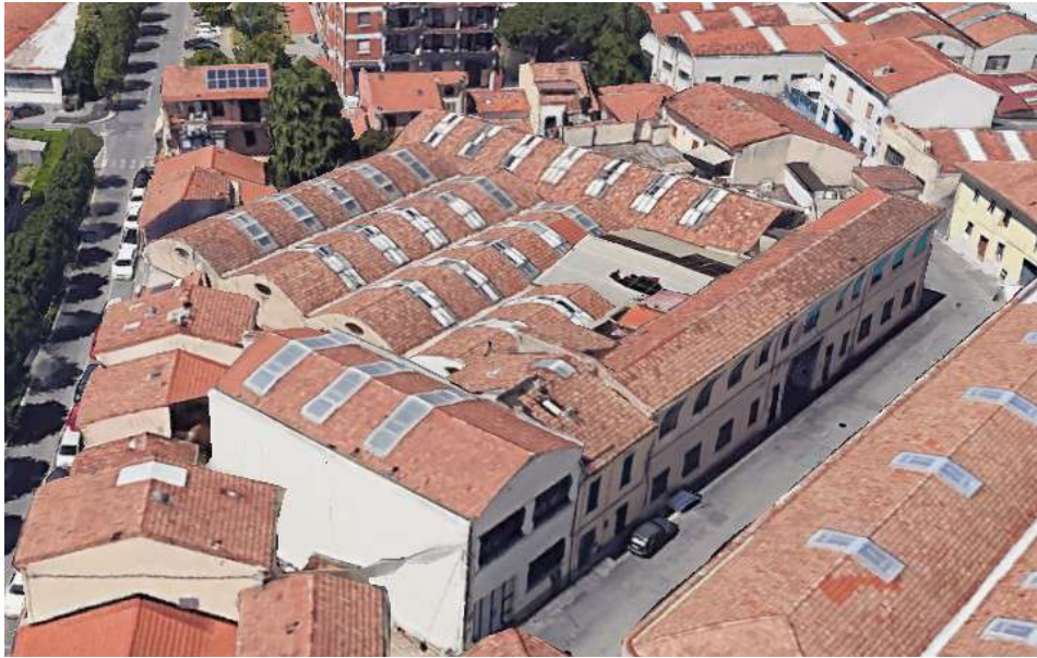
Fabbrica via San Paolo
