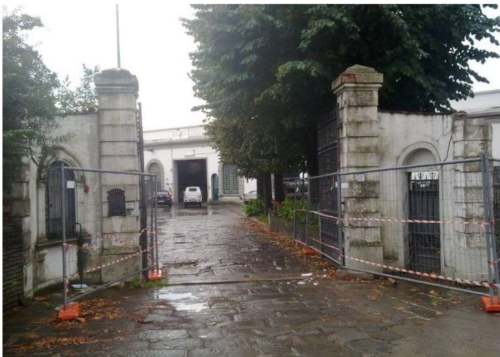
Ingresso principale al piazzale interno in una foto del 2015 prima della sua demolizione
