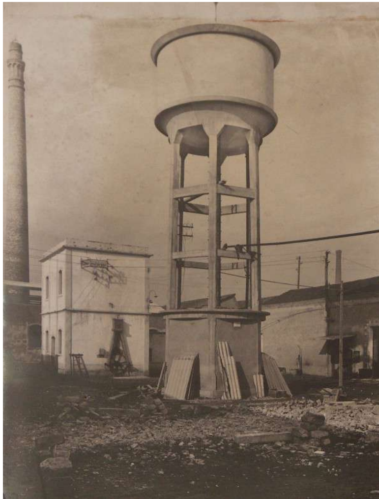
Deposito aereo in cemento armato appena realizzato
