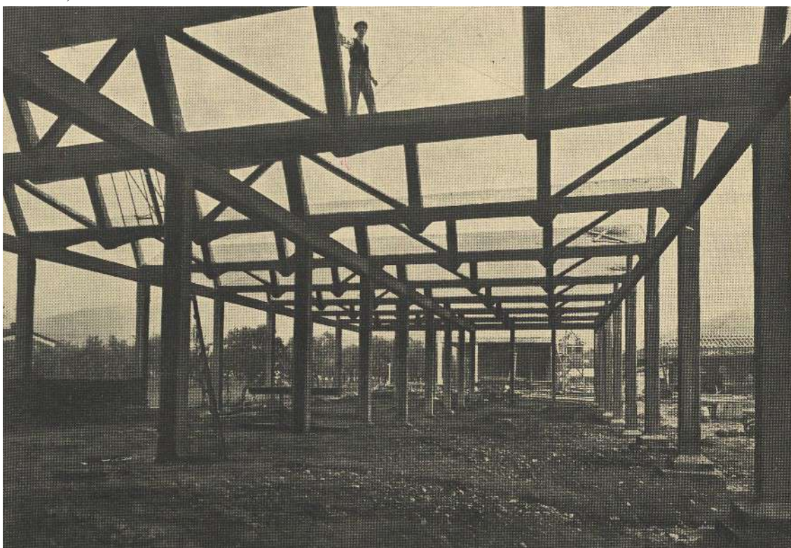
Cantiere per la costruzione dei capannoni a sheed – 1928 (Album dei lavori realizzati dalla Nervi & Nebbiosi)
