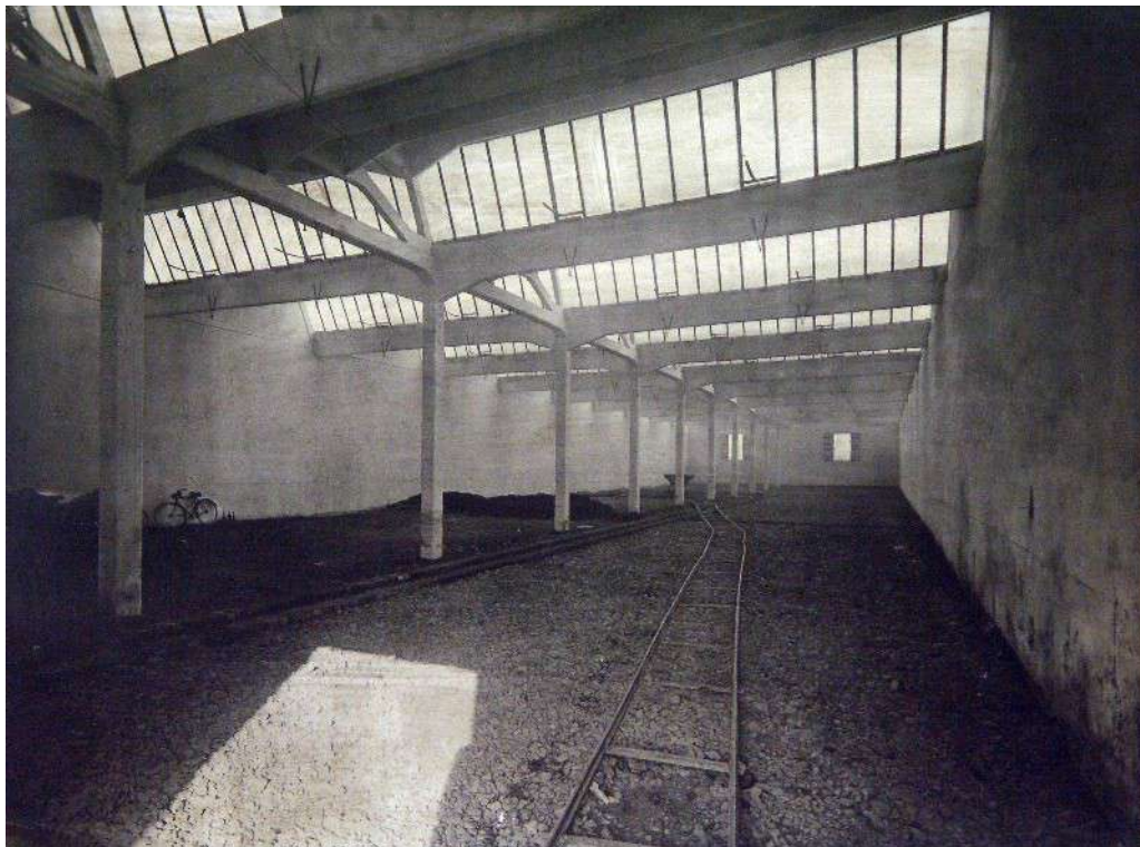
Interno di uno dei capannoni appena realizzato
