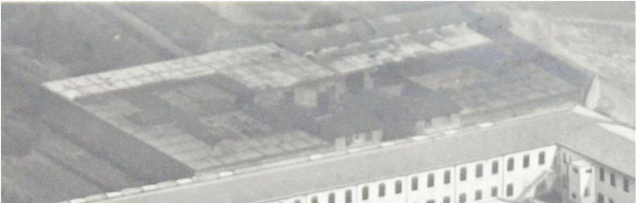
Frammento di foto aerea dello stabilimento Michelangelo Calamai della prima metà del Novecento, in cui si vede attiguo il complesso Reali-Bessi ancora tutto ad un unico livello coperto a terrazza. (Cartolina pubblicitaria)
