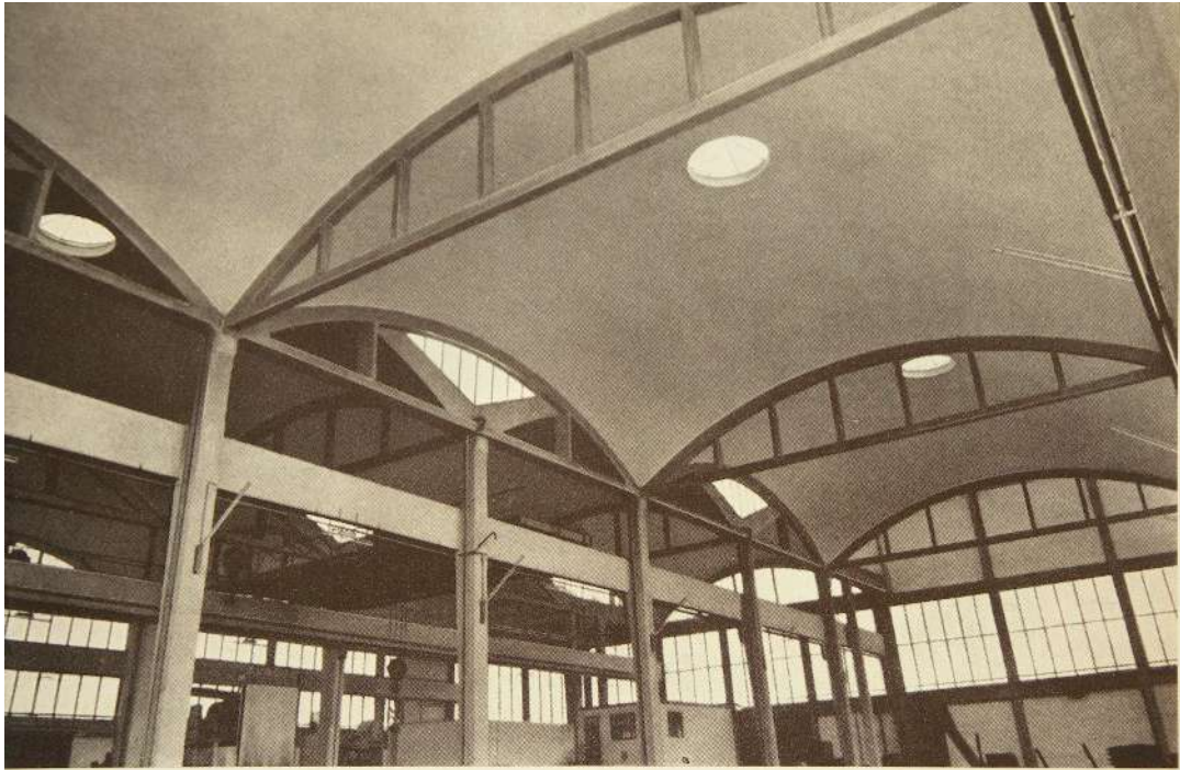
Veduta interna della fonderia dopo la sua realizzazione ("Il Laterizio" Bollettino tecnico Erredibi, n° 130, anno 22, ottobre 1971, pp. 890-891)
