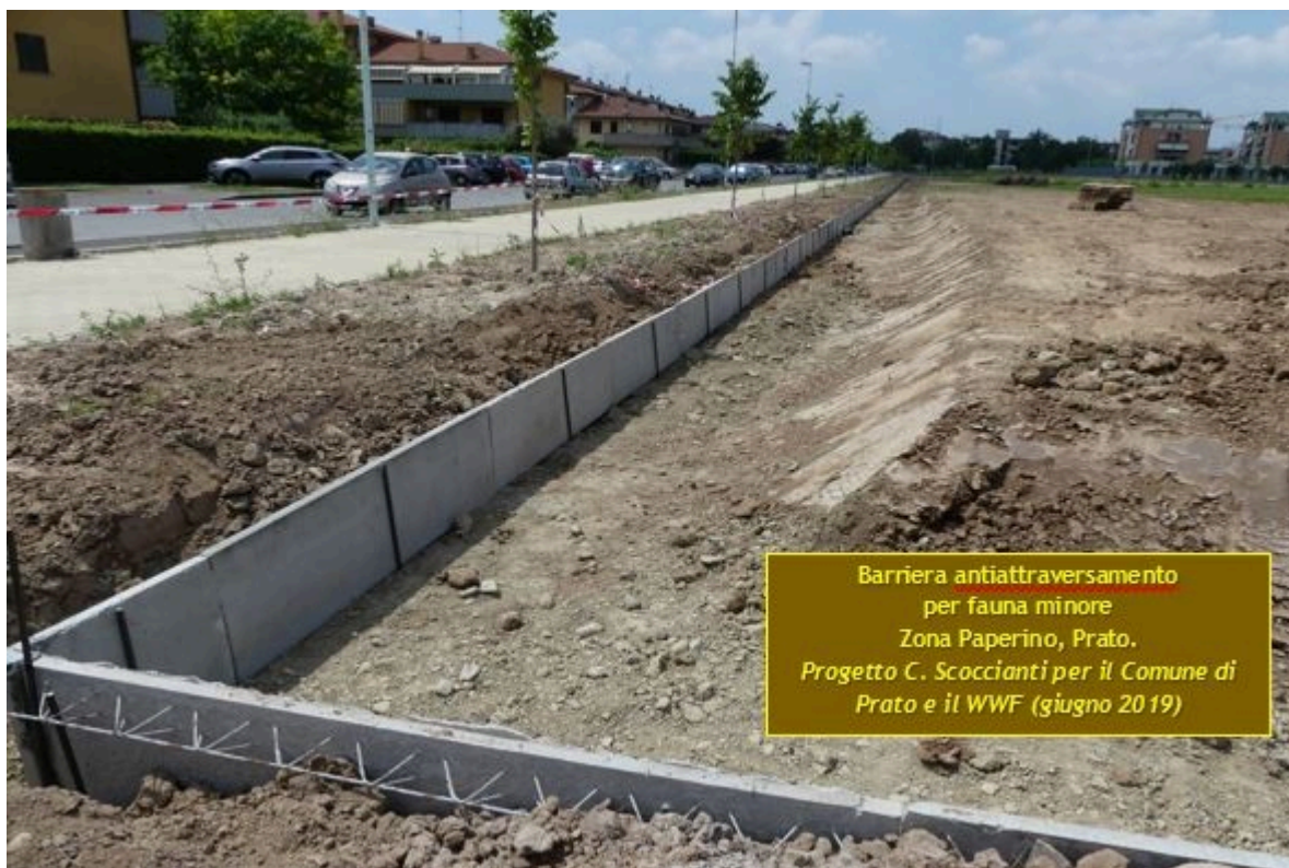
Figura 5 - Ultime fasi di costruzione di una barriera antiattraversamento per la tutela della fauna di piccole dimensioni presso l'area di interesse erpetologico in località 'Paperino', Comune di Prato.
