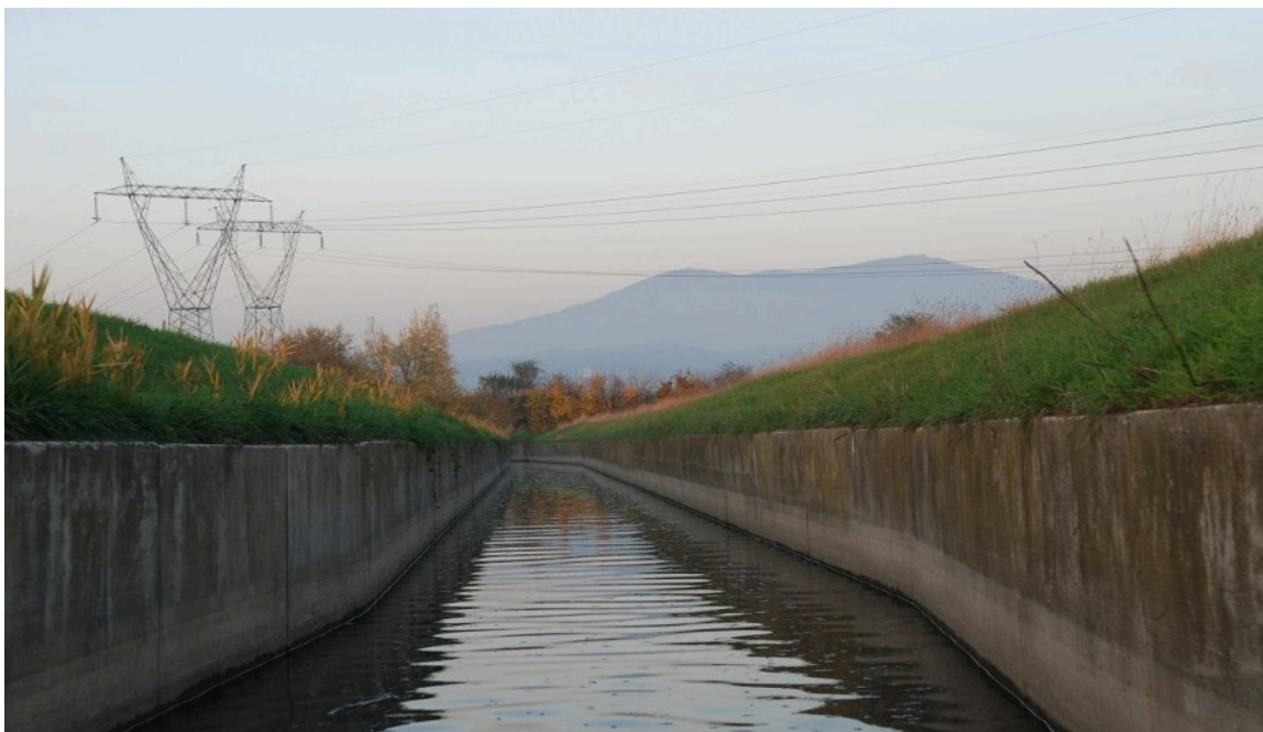
Figura 2: Un tratto di canale con pareti verticali. Si tratta del canale Garille al centro della Piana Fiorentina. Strutture come queste sono causa ogni anno della caduta e della conseguente morte di decine e decine di individui di varie specie faunistiche. Un lungo tratto di questo canale che passava all'interno dell'Oasi WWF Stagni di Focognano è stato completamente rinaturalizzato nel 2011 (Progetto: WWF – Comune di Campi Bisenzio – Consorzio di Bonifica) proprio per evitare ogni impatto sulle specie (Archivio WWF per la Toscana – Foto C. Scoccianti – Anno 2010)
