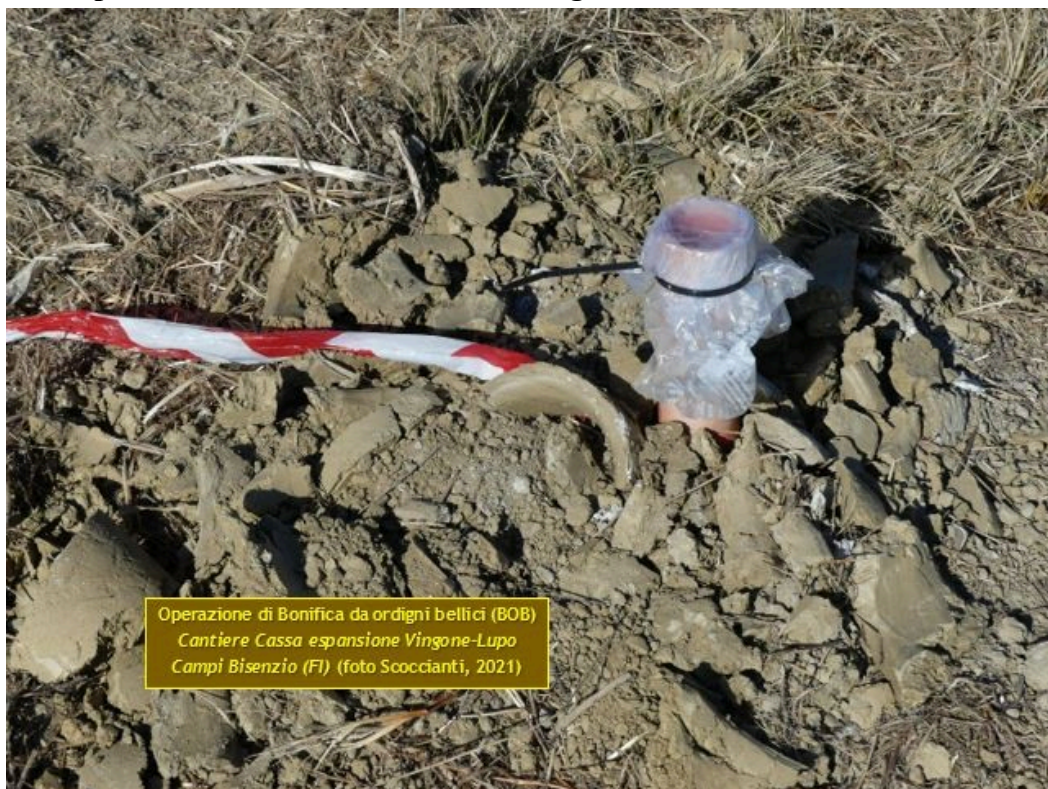
Figura 9 – Chiusura dei fori di trivellazione subito dopo l'esecuzione del sondaggio di ricerca degli ordigni bellici (BOB) e mantenimento, in accordo con l'apposito reparto dell'Esercito, di un numero adeguato di fori (incamiciati con tubi pvc muniti di tappo), per permettere il controllo finale (collaudo) da parte dello stesso reparto dell'Esercito. Cantiere Cassa espansione Vingone-Lupo, Campi Bisenzio (FI) (Foto C. Scoccianti – Anno 2021)
