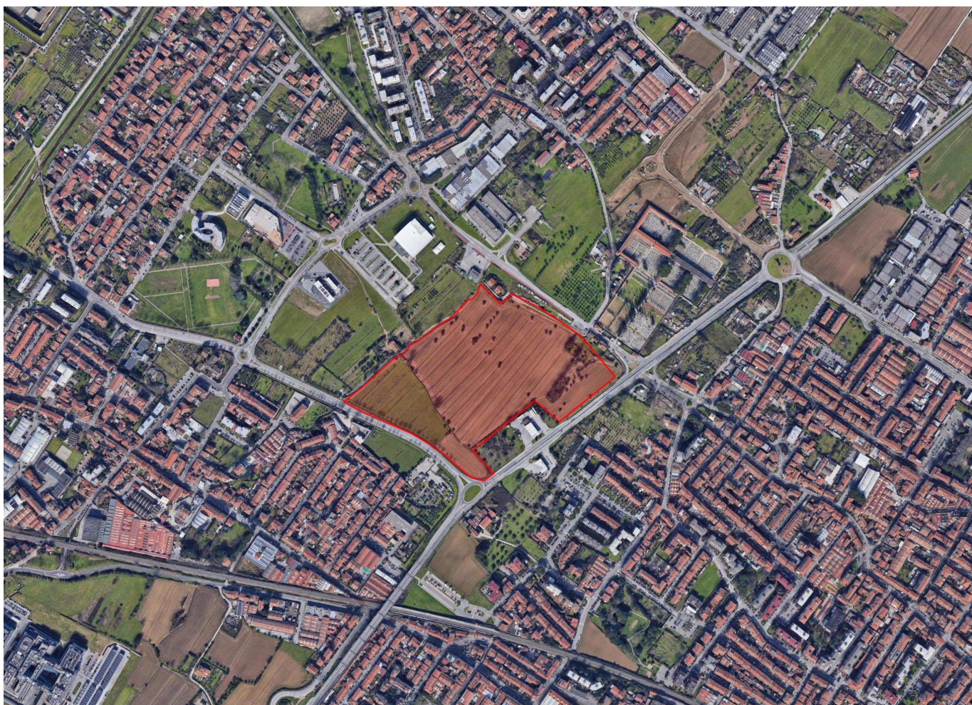
Inquadramento dall'alto dell'area di intervento
