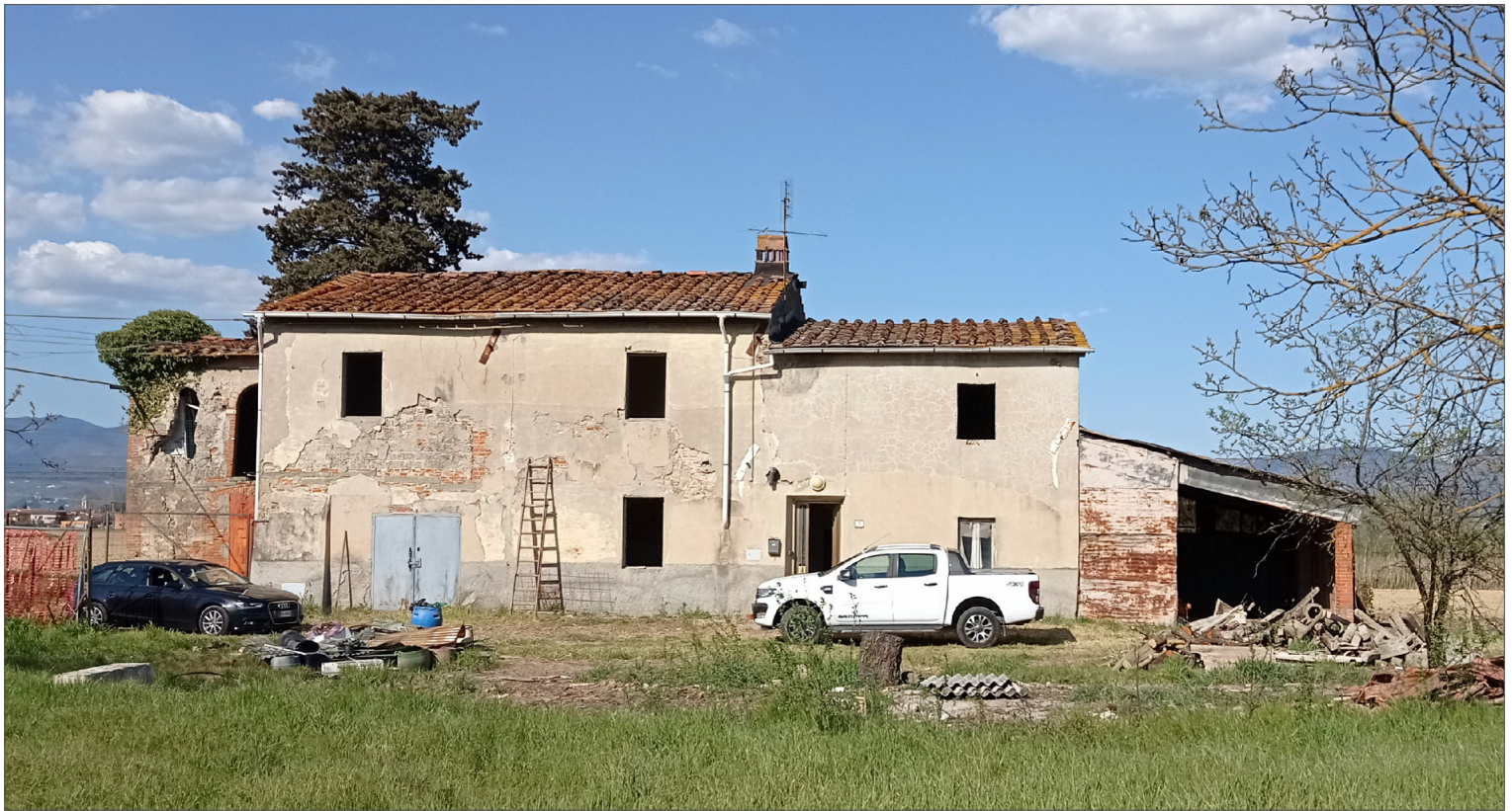
Foto stato attuale
