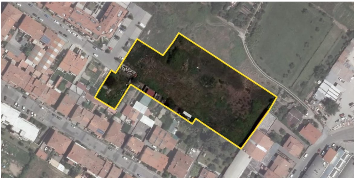
INQUADRAMENTO AREA DI ATTERRAGGIO UMI 1 E 2, VIA BRIONI
