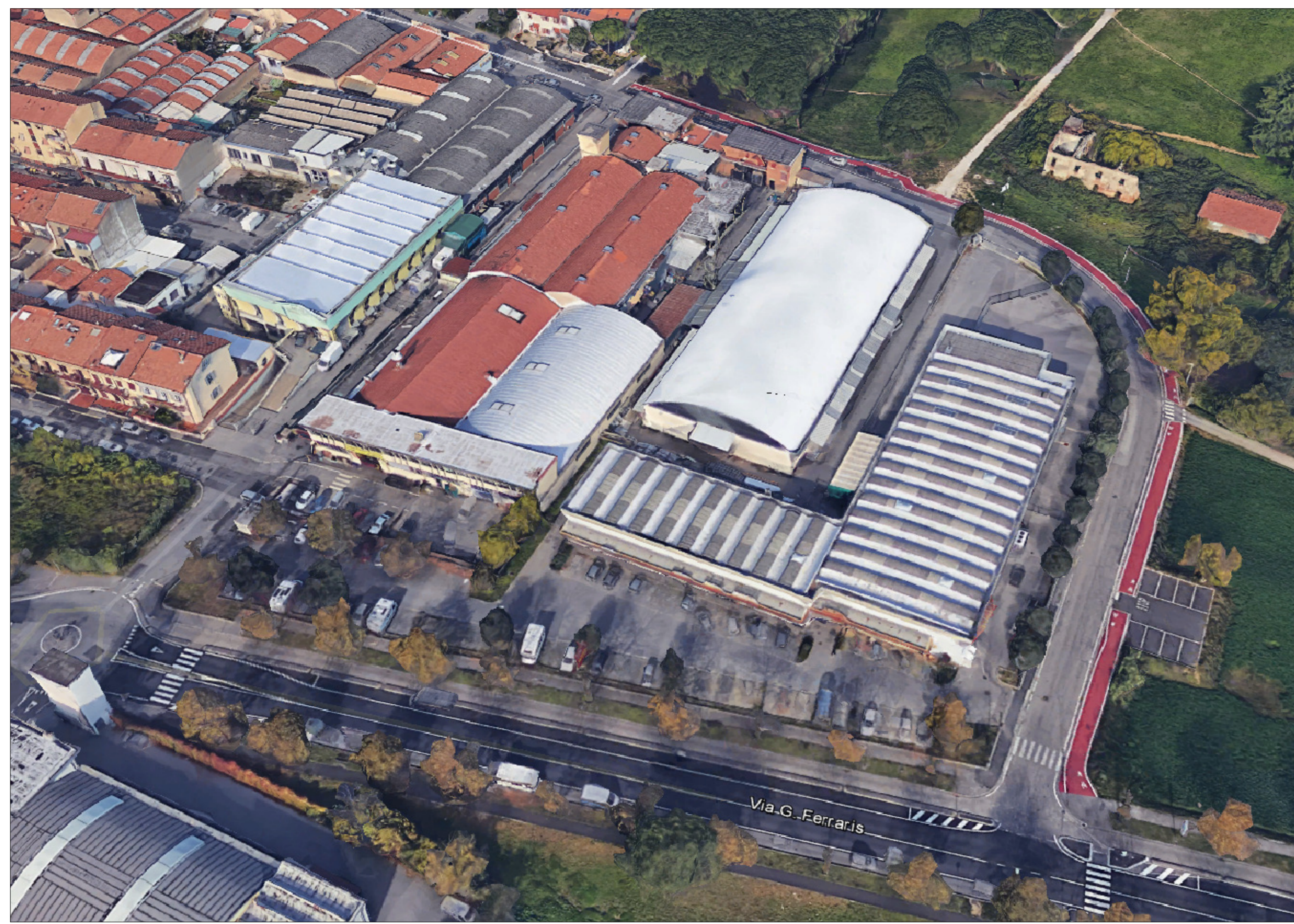
Foto aerea "vista SUD"
