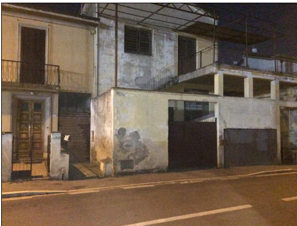
Figura 5: Vista dell'area in oggetto da via Mugnaini (Notturno)
