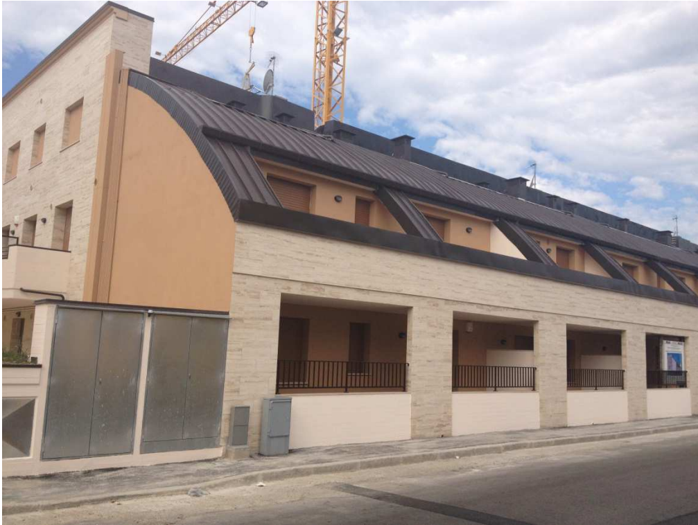
9 Nuovo intervento residenziale in via Ciampi
