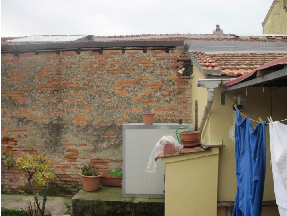
79 I laboratori Bellucci visti dal resede dell'abitazione posta in adiacenza
