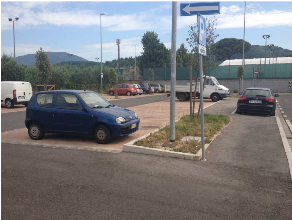
16 Parcheggio pubblico di recente realizzazione al termine di via Mugnaini
