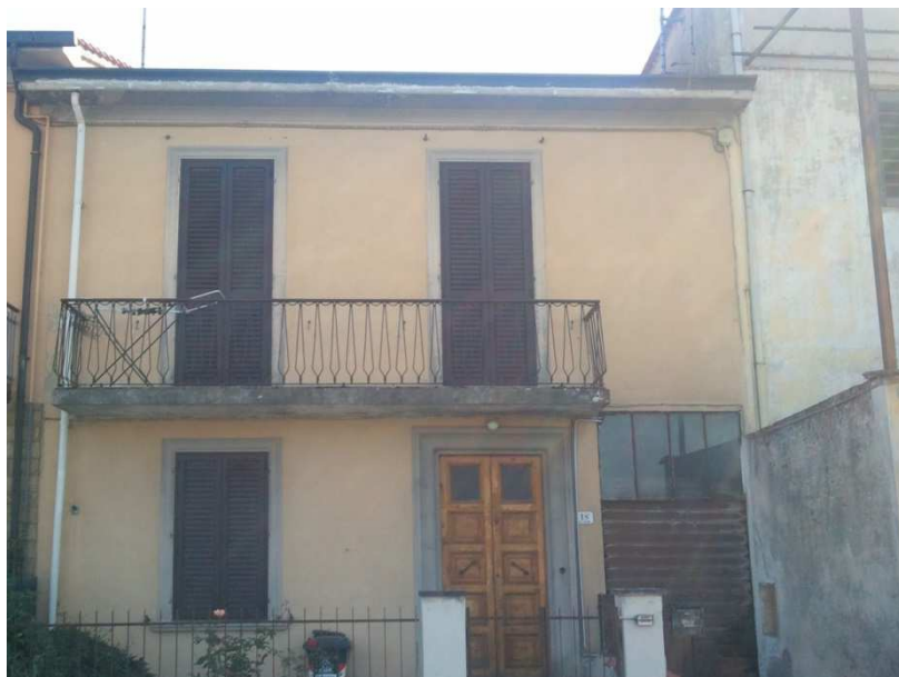
6 Abitazione di proprietà Bellucci su via Mugnaini, accanto ai laboratori artigianali
