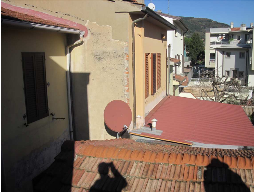
37 Particolare del tetto di uno dei laboratori artigianali, le facciate tergalì delle case a schiera e il nuovo intervento residenziale con tipologia in linea
