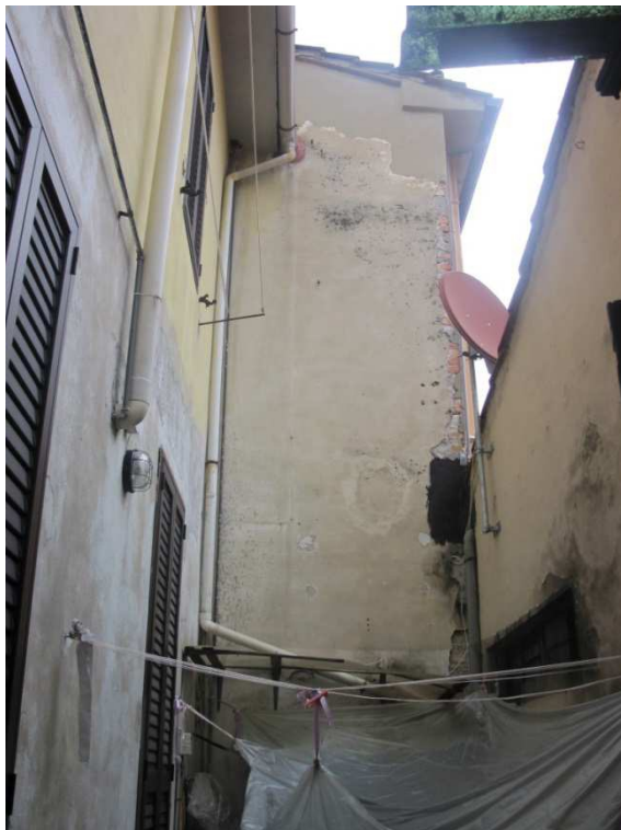
62 Facciata tergale dell'abitazione con il laboratorio nella zona tergale
