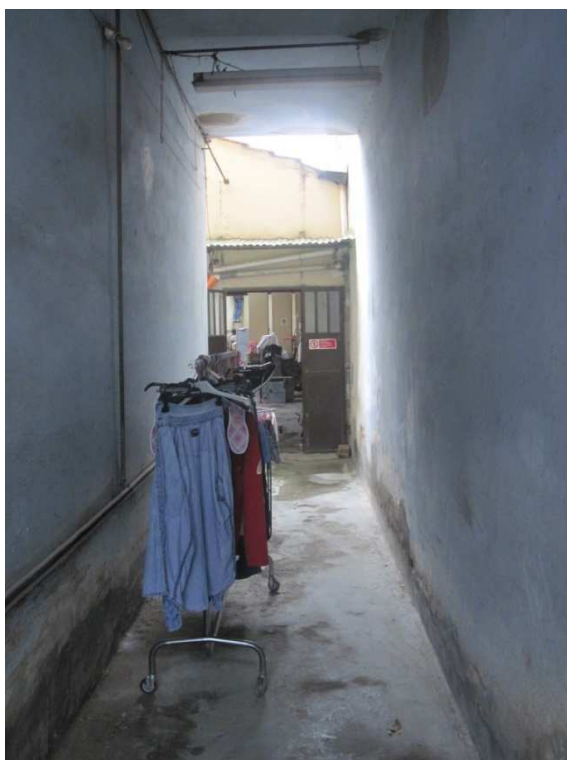
64 particolare del passaggio sotto il piano primo dell'abitazione per l'accesso ad uno dei laboratori artigianali posti in seconda schiera
