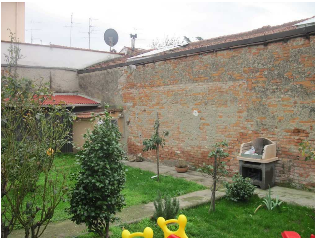
80 I laboratori Bellucci visti dal resede dell'abitazione posta in adiacenza
