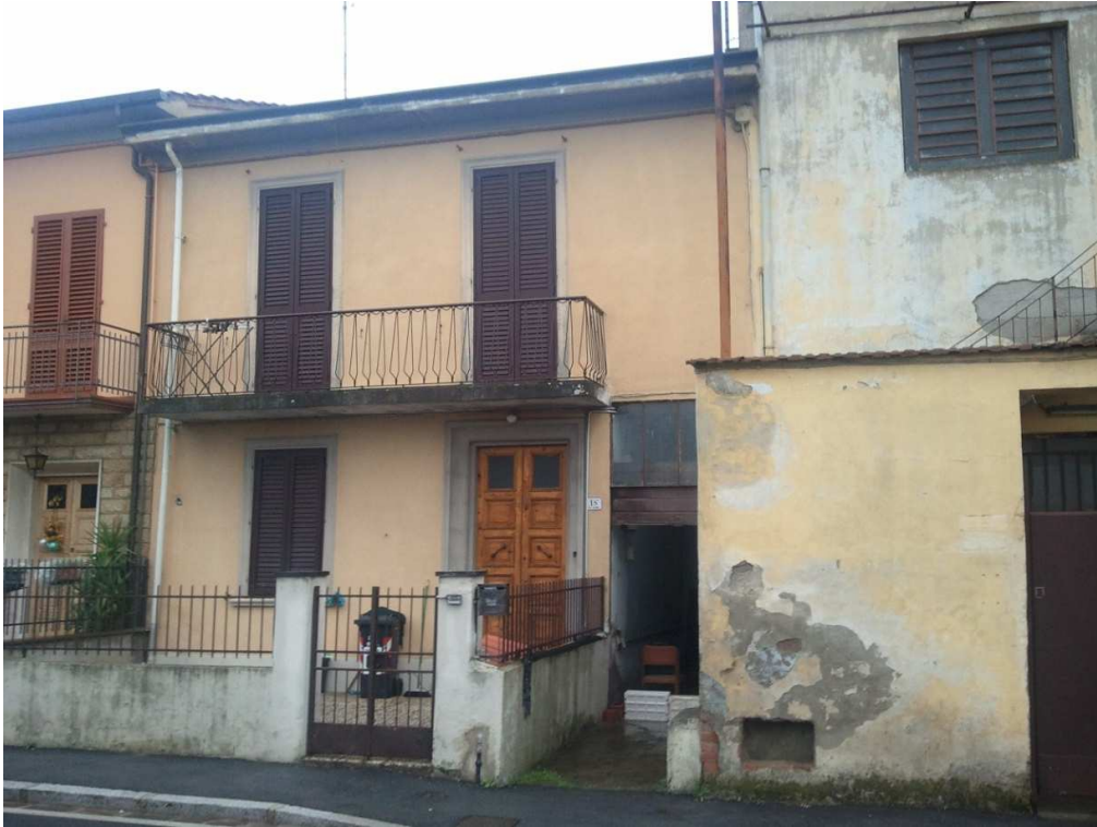
5 Abitazione di proprietà Bellucci su via Mugnaini, accanto ai laboratori artigianali
