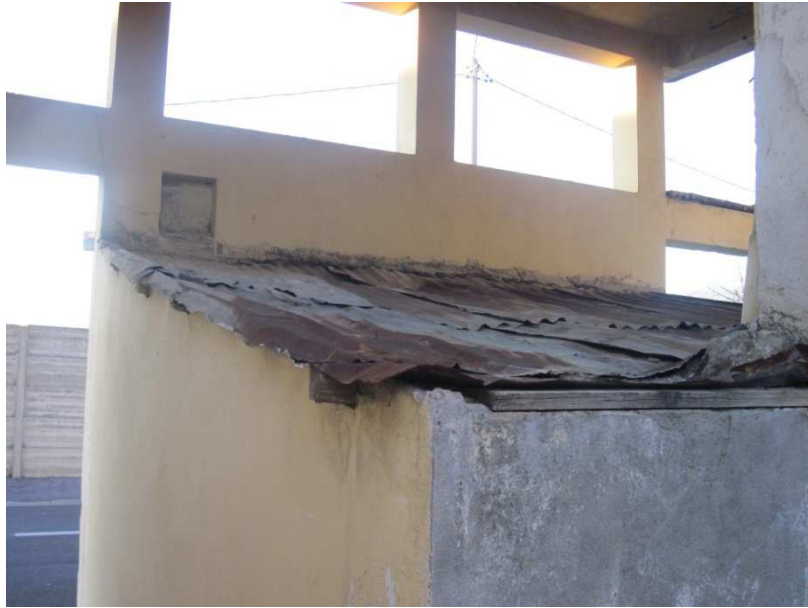
67 La piccola autorimessa
