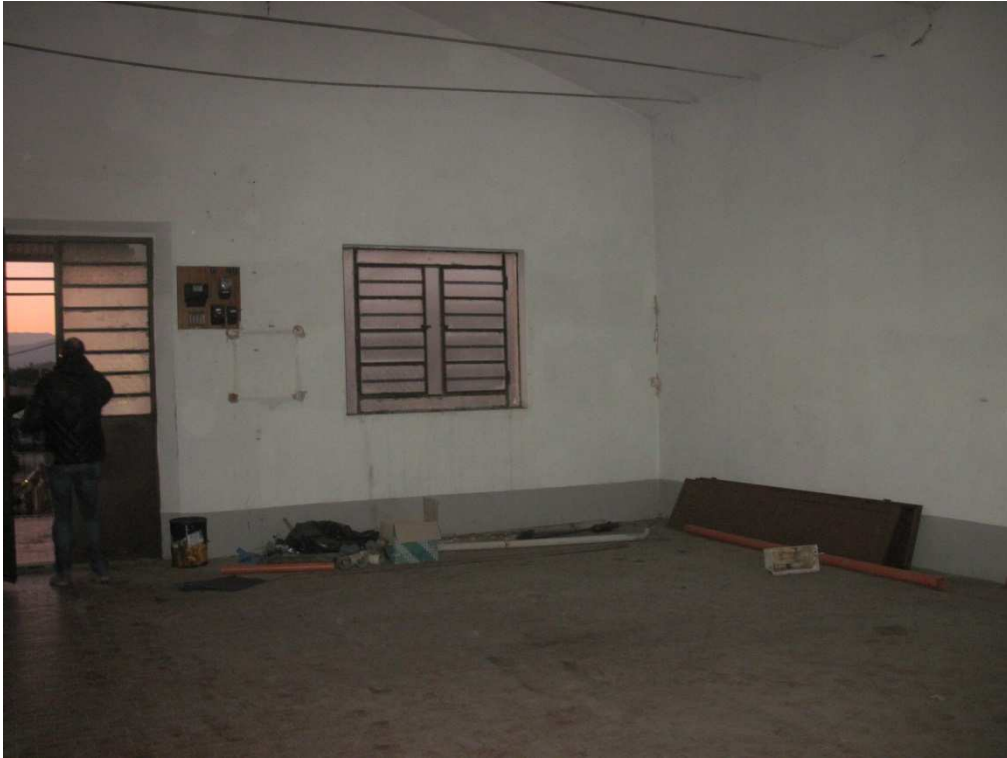
33 interno piano primo
