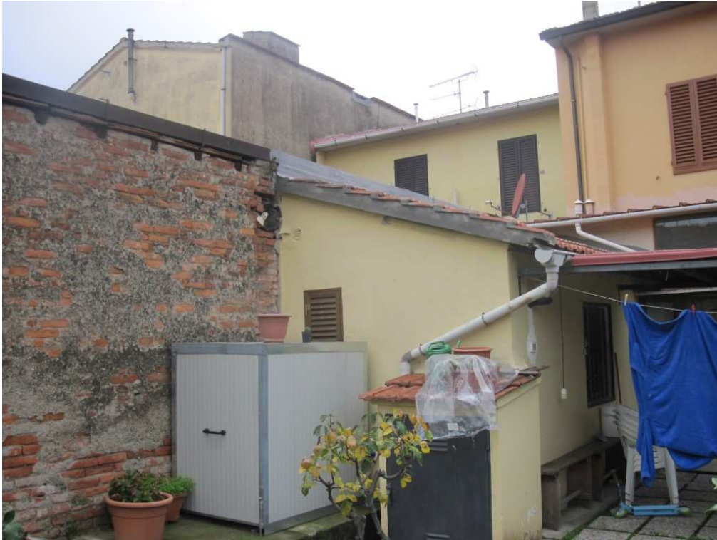
81 I laboratori Bellucci visti dal resede dell'abitazione posta in adiacenza
