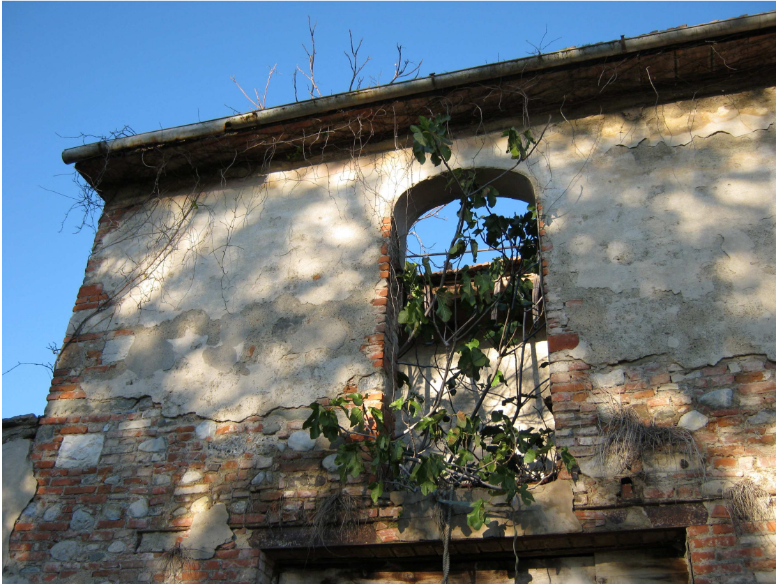
Foto 6 – Particolare prospetto principale.
