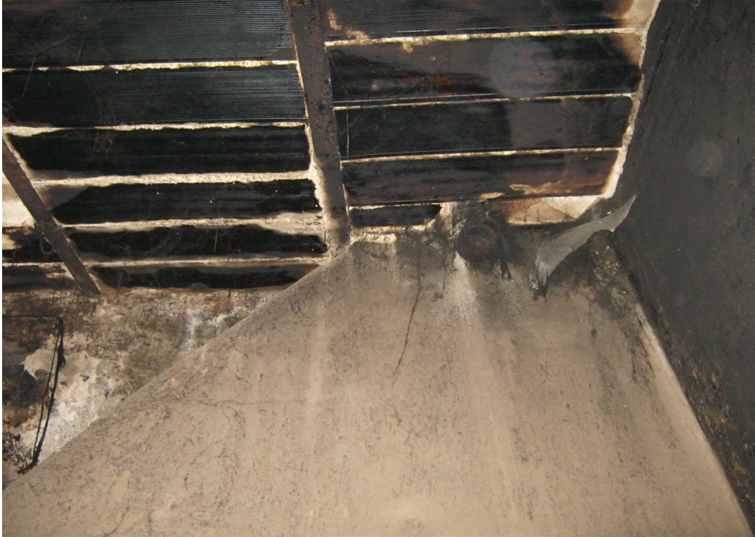
Foto 18 -Particolare interno. Ambiente cucina.
