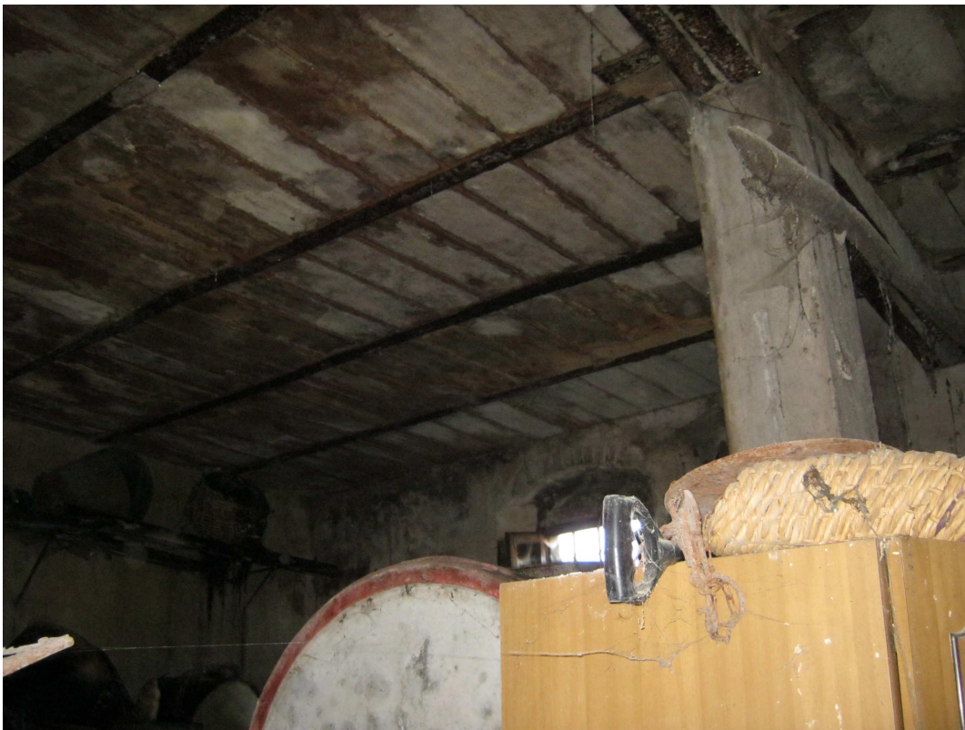
Foto 19 -Particolare interno. Ambiente cantina
