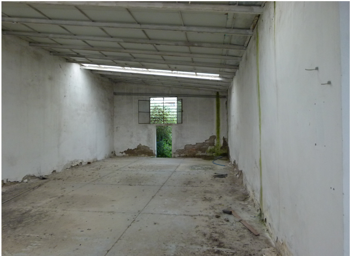
foto 3 – interno del blocco 1 – pavimentazione in cemento industriale
