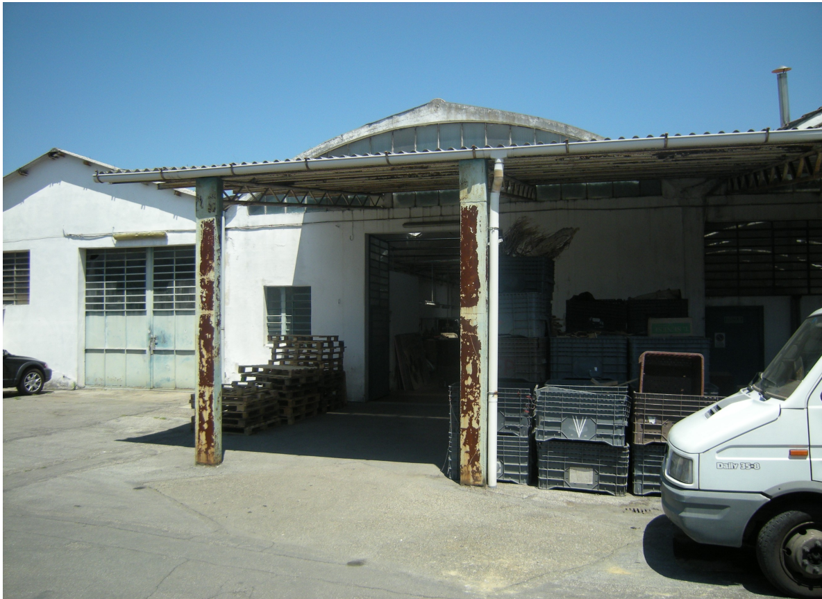
foto 7 – accesso al blocco 3
