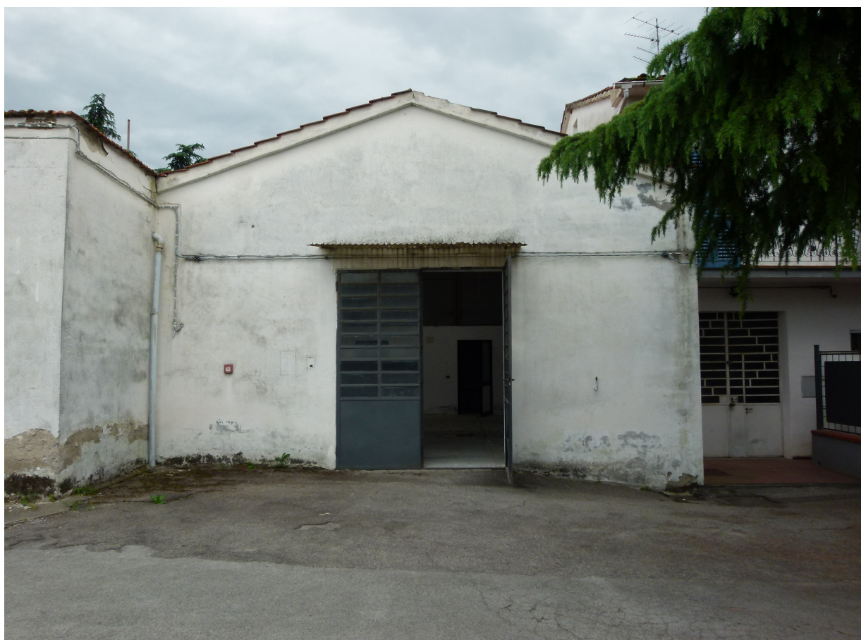
foto 1 – accesso al blocco 1
