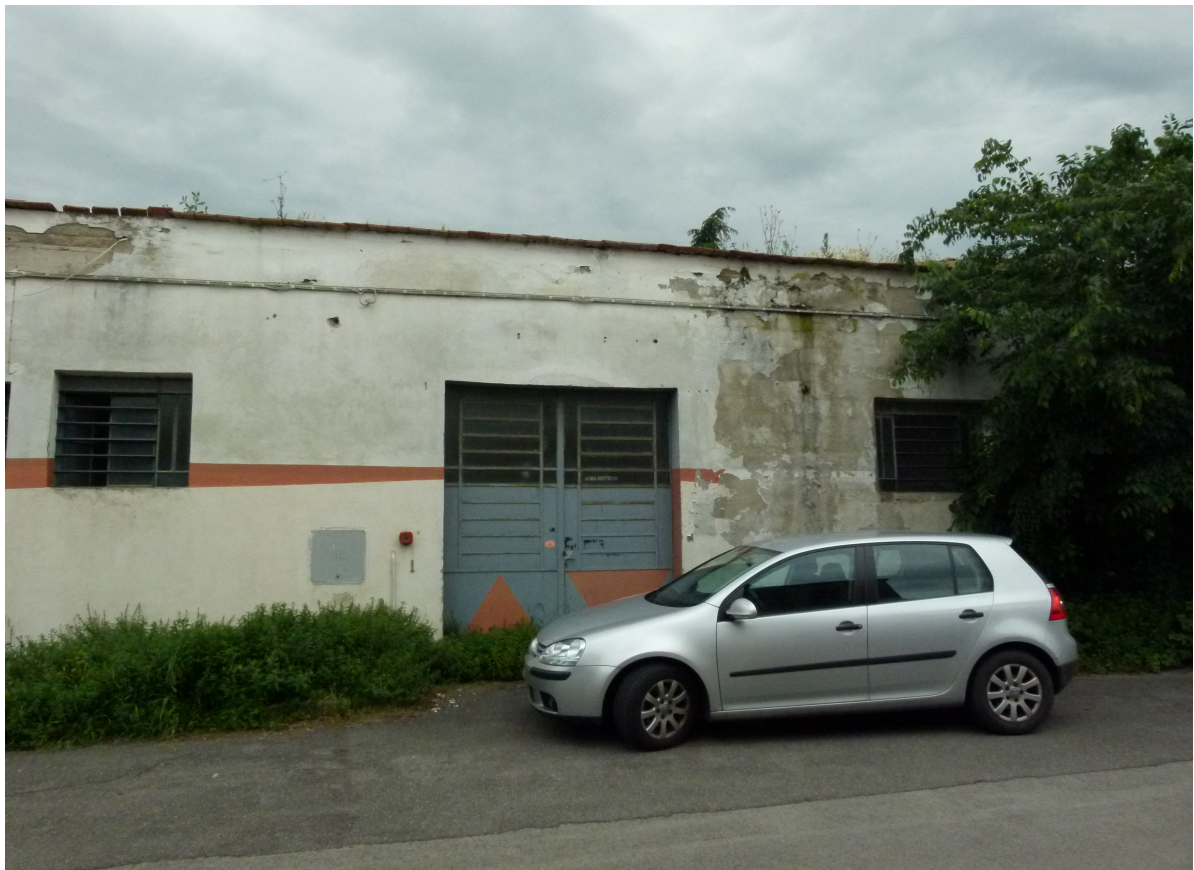
foto 4 – accesso al blocco 2
