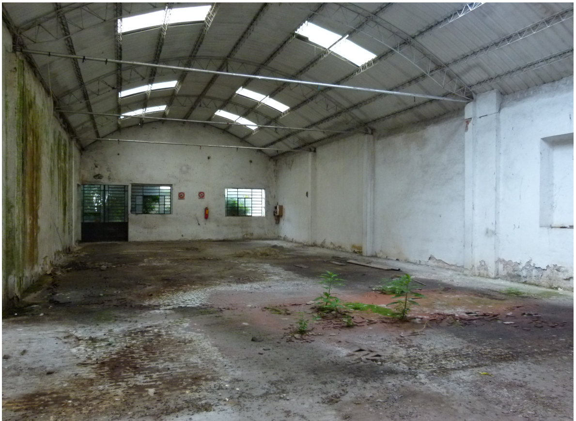
foto 6 – interno del blocco 2 – evidente la copertura a volta in eternit e la pavimentazione in klinker macchiata dagli olii dei macchinari
