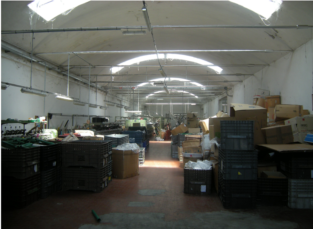
foto 9 – interno del blocco 3 - in evidenza la pavimentazione in klinker
