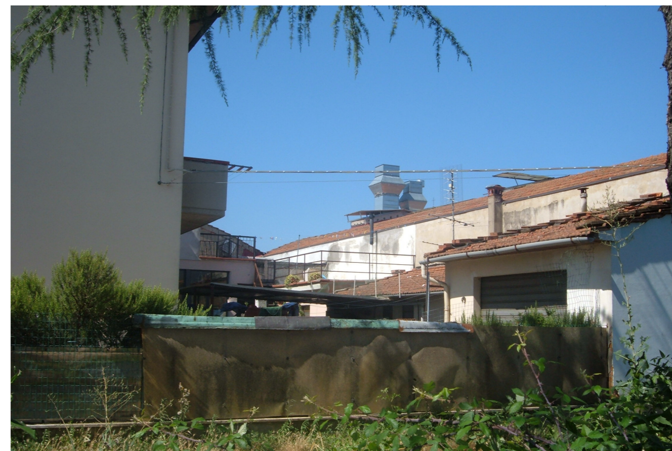
FOTO 16 - Particolare del capannone
