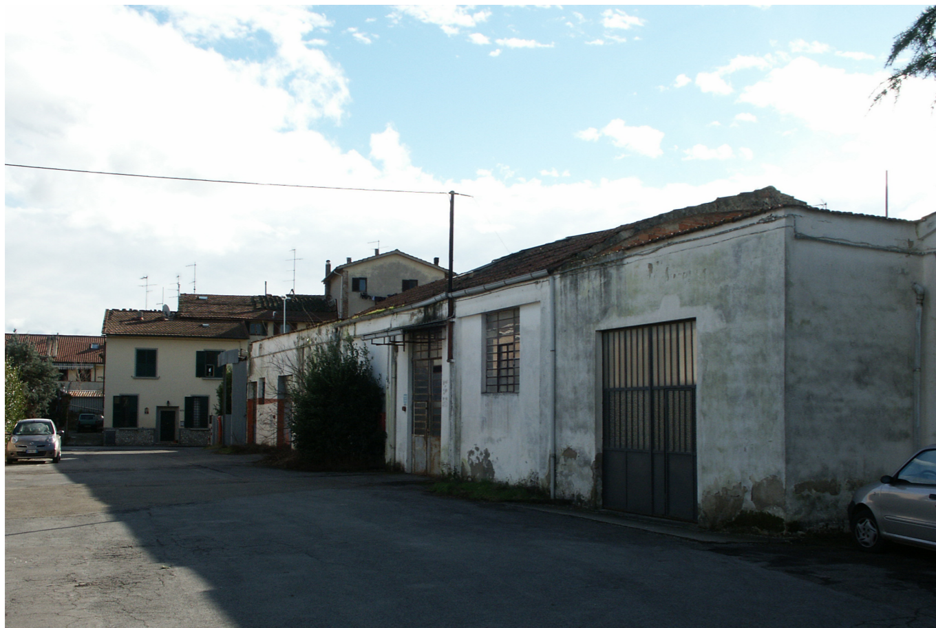
FOTO 5 - Vista dei capannoni artigianali dal lato nord-est
