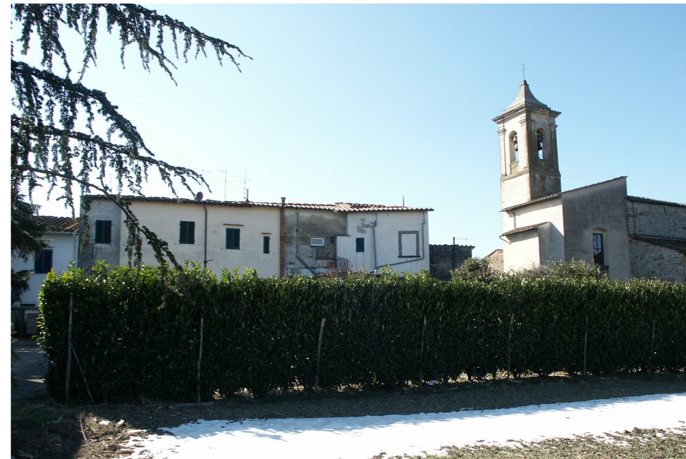
FOTO 6 - Vista del contesto e della chiesa dal lato sud-ovest
