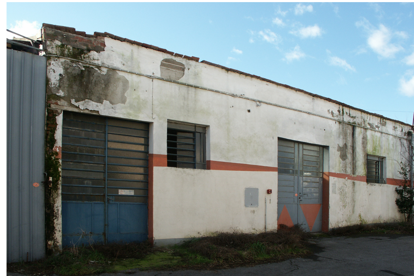
FOTO 2 - Viabilità interna da via delle Fonti
