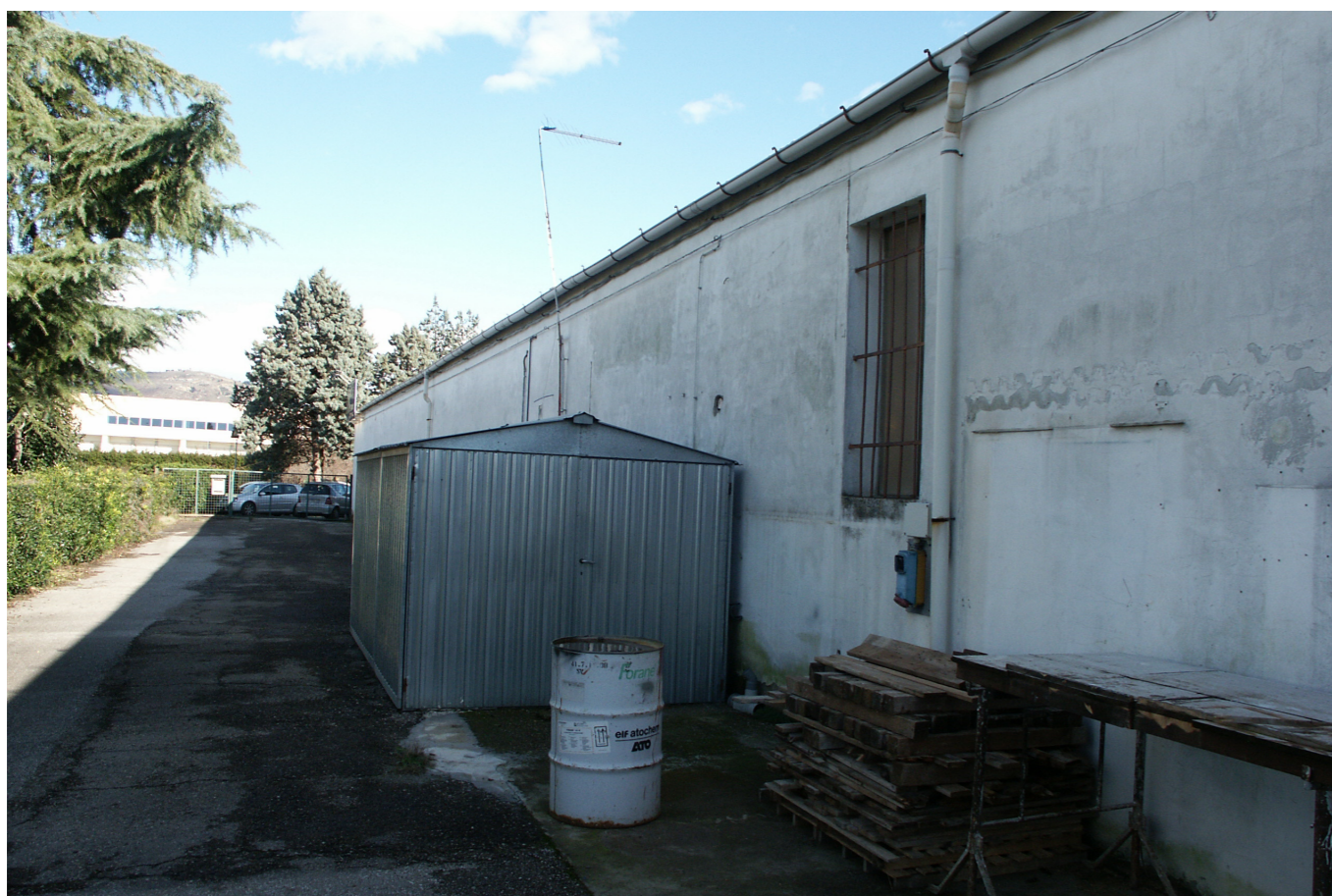
FOTO 11 - Vista del capannone dal lato nord-ovest
