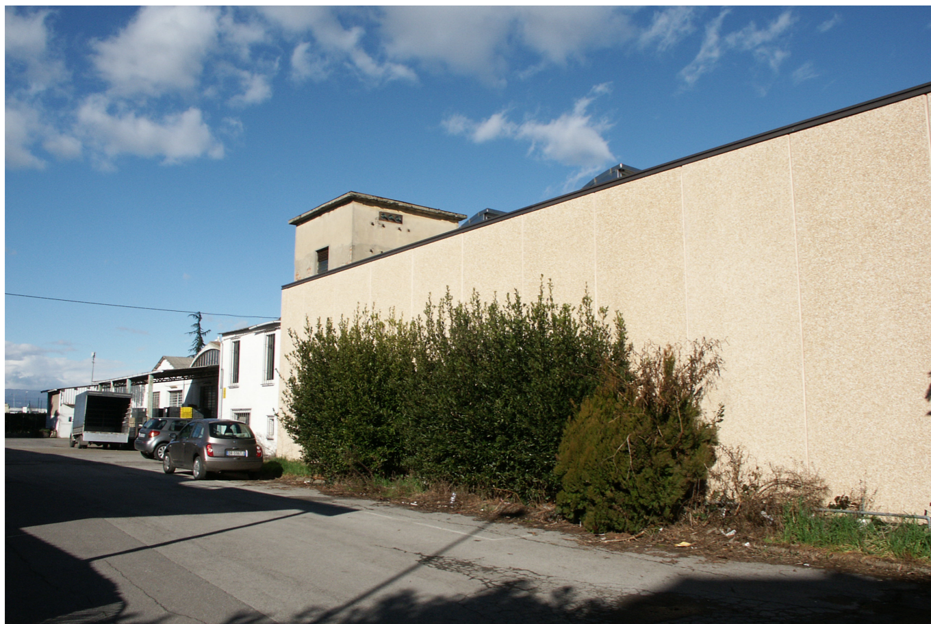
FOTO 1 - Viabilità interna da via delle Fonti
