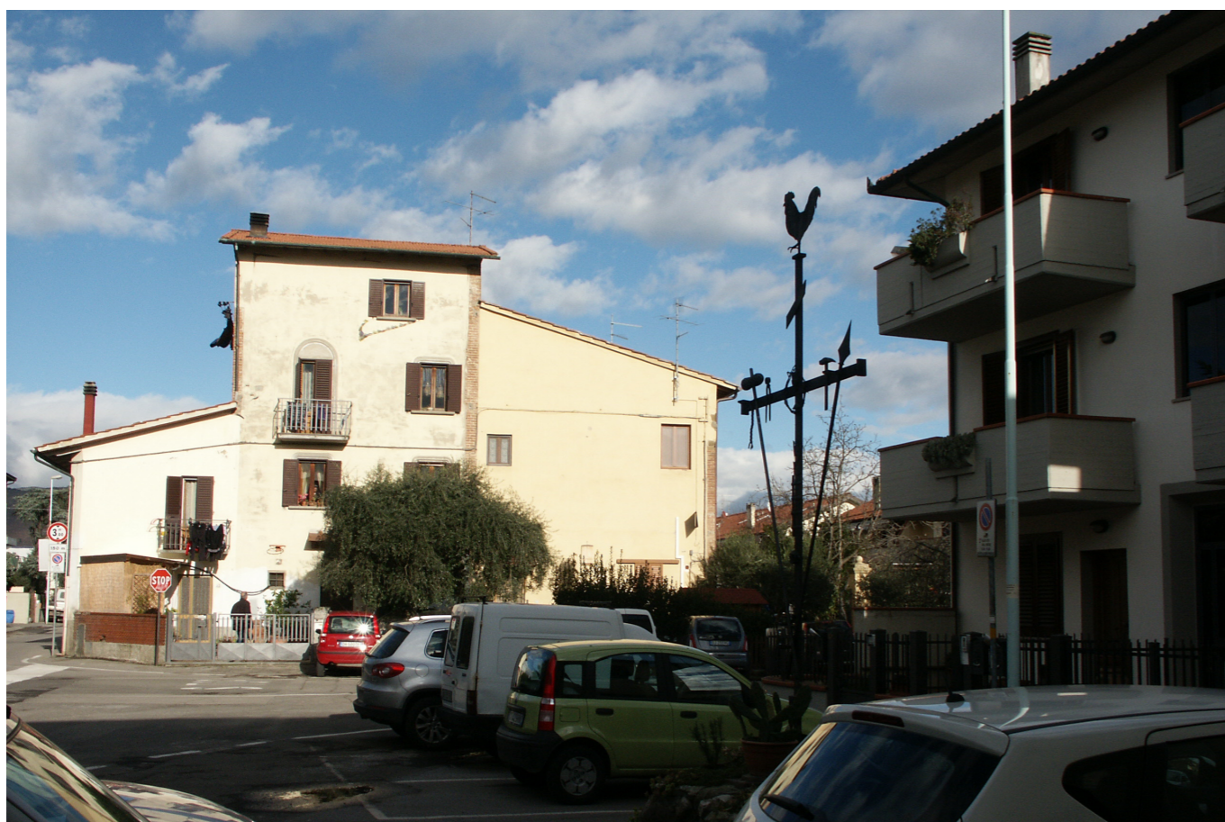
FOTO 11 - Via del Campostino
