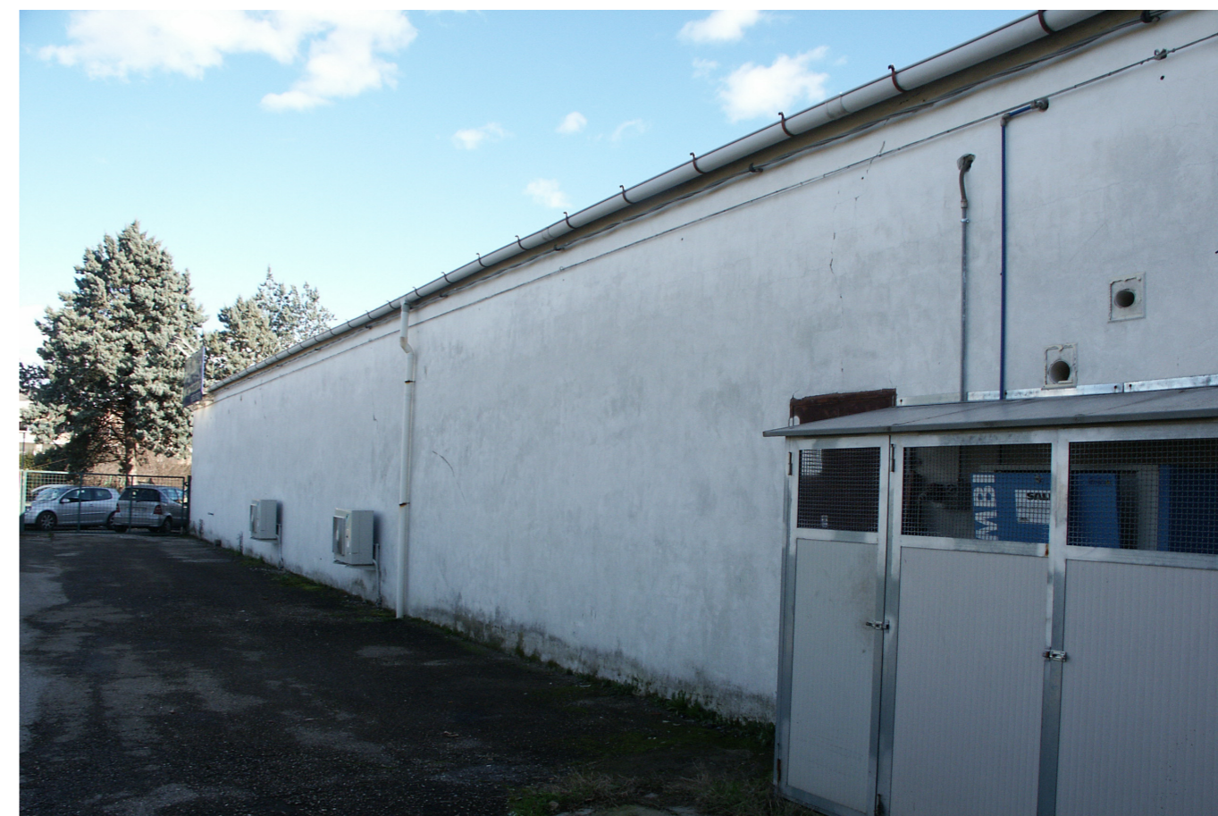
FOTO 12 - Particolare del capannone
