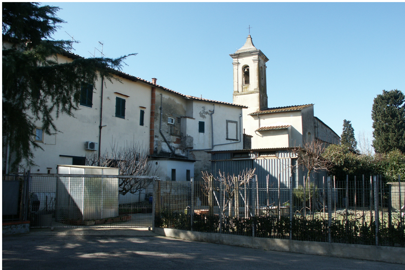
FOTO 1 - Vista del contesto circostante e della chiesa dal lato sud-ovest
