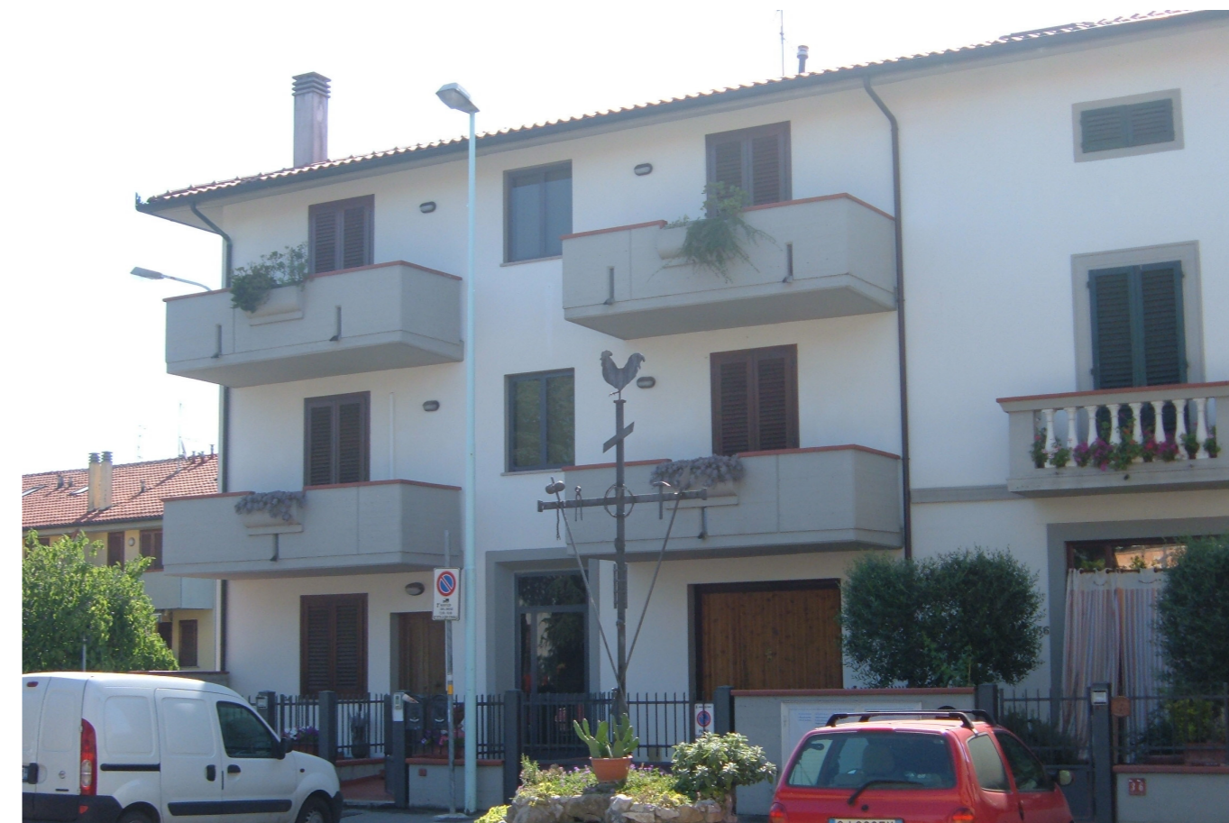
FOTO 12 - Via del Campostino
