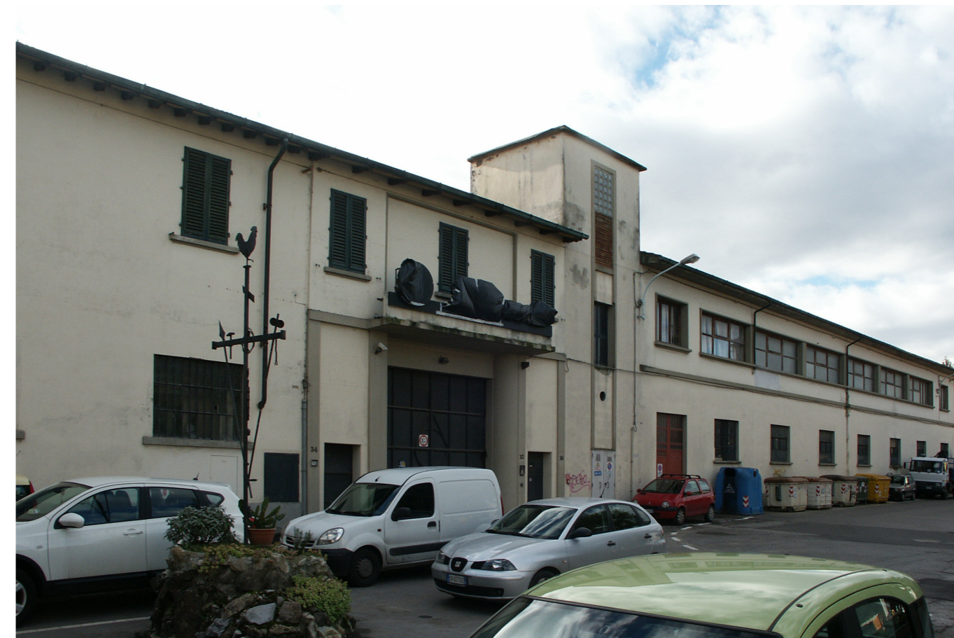
FOTO 10 - Via del Campostino
