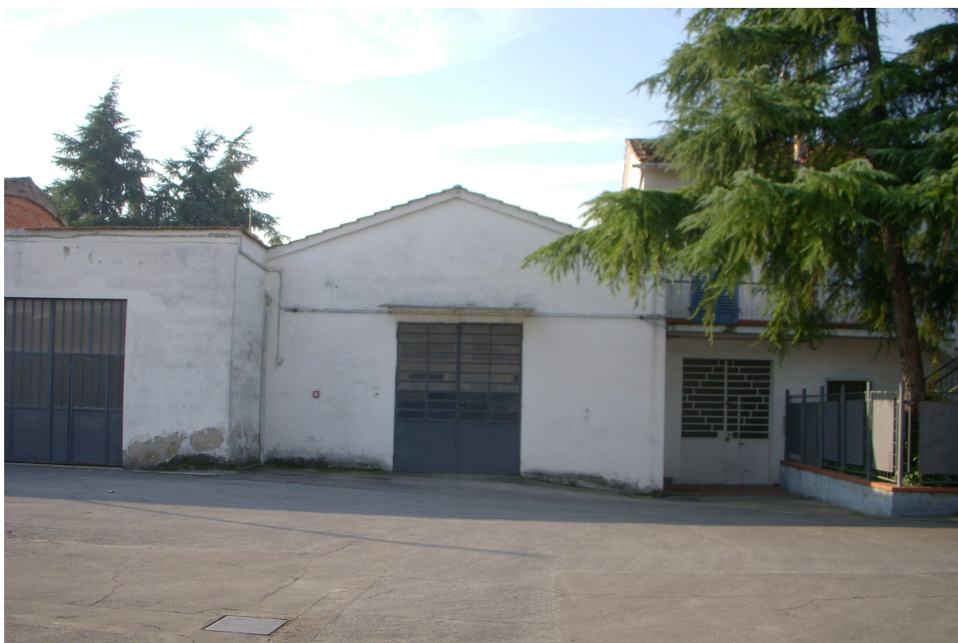
FOTO 7 - Vista dei capannoni artigianali dal lato nord-est
