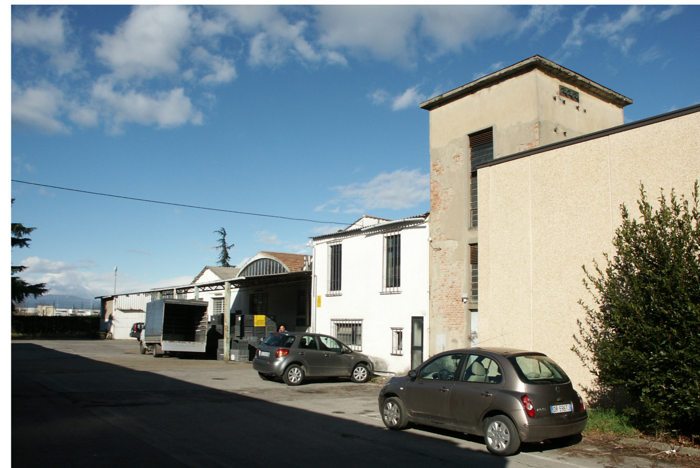
FOTO 2 - Viabilità interna da via delle Fonti
