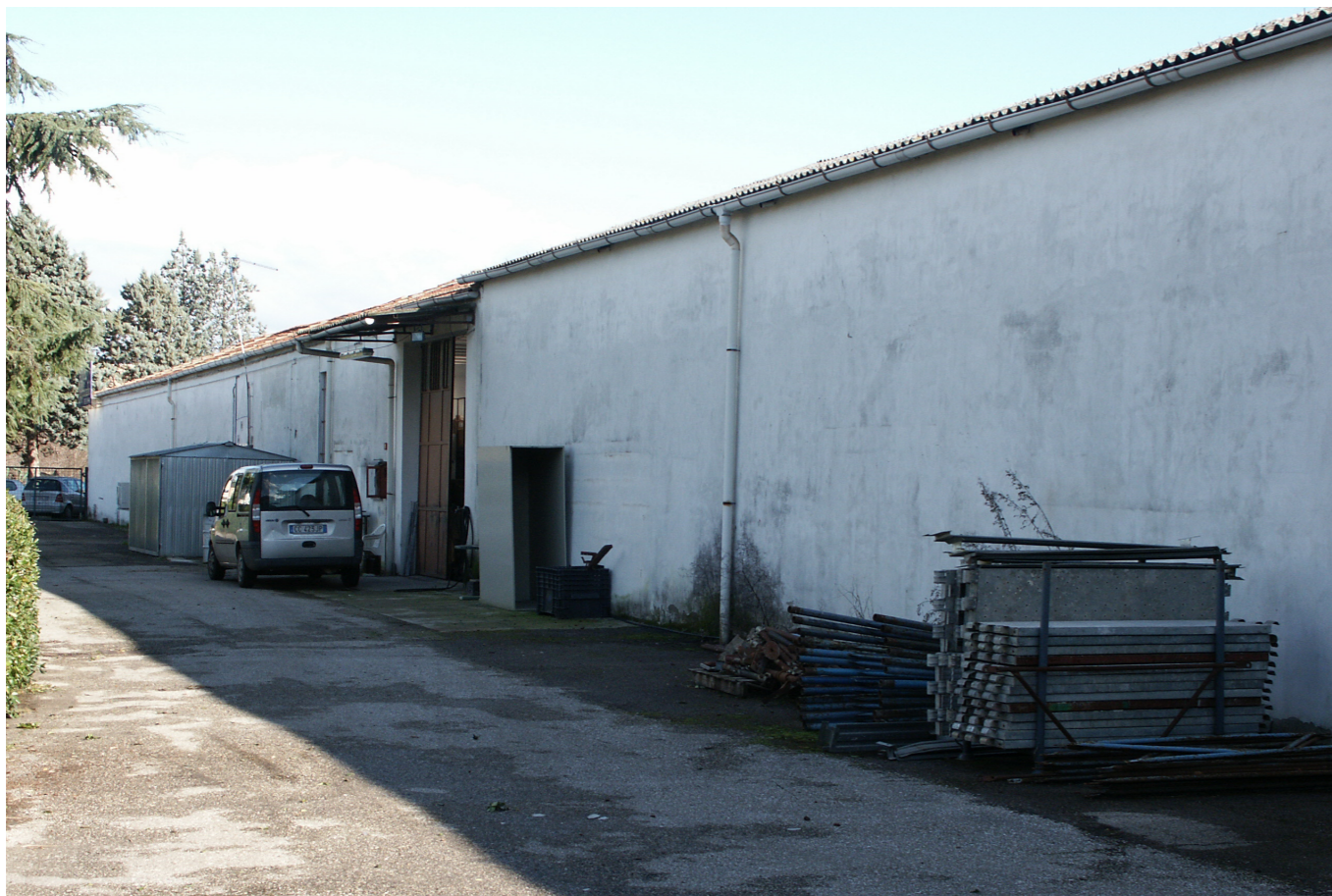
FOTO 9 - Vista del capannone dal lato nord-ovest
