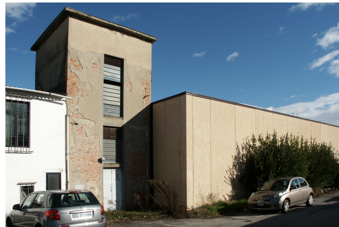
FOTO 4 - Particolare dei capannoni e della cabina elettrica
