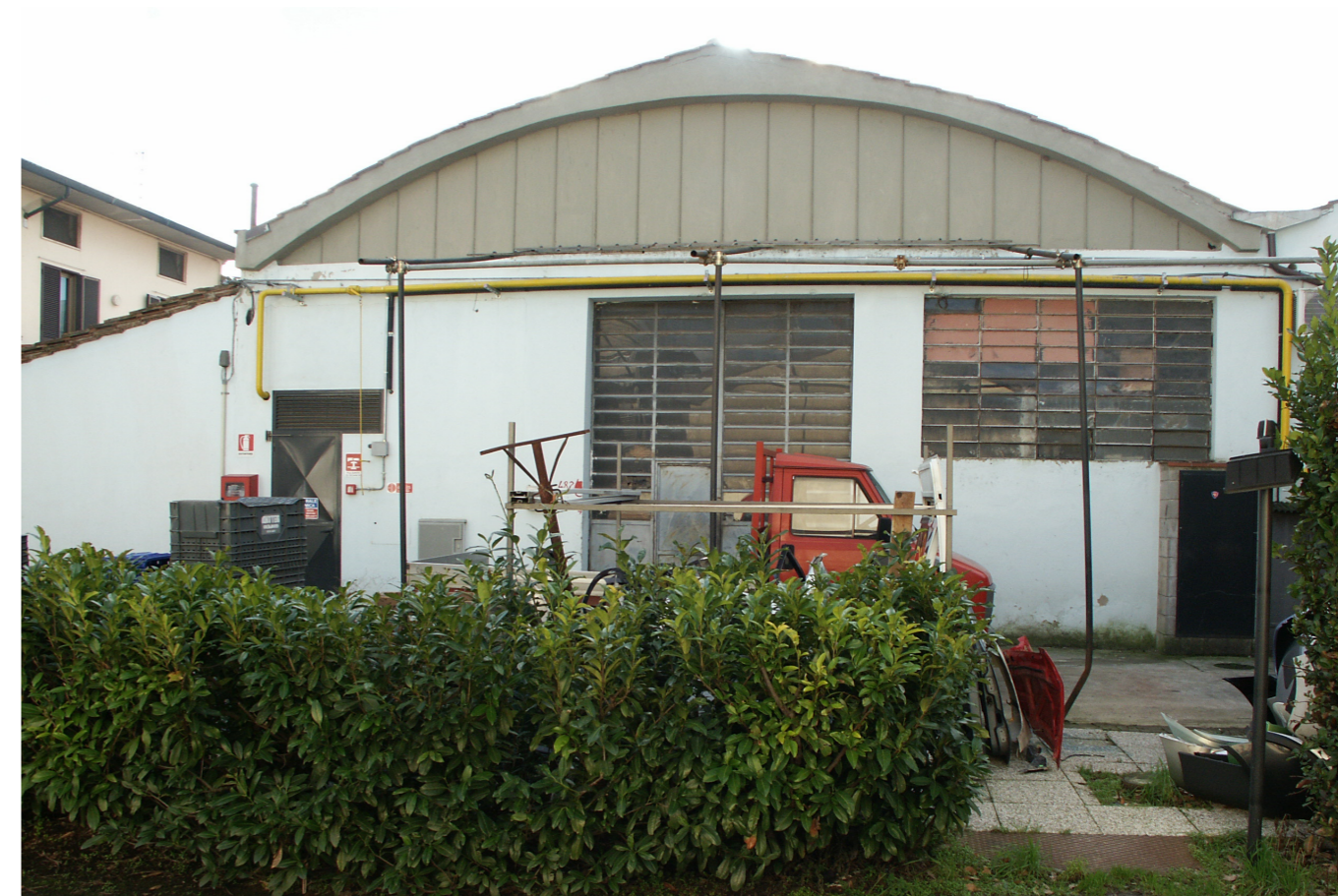
FOTO 14 - Vista dei capannoni artigianali dal lato nord-est
