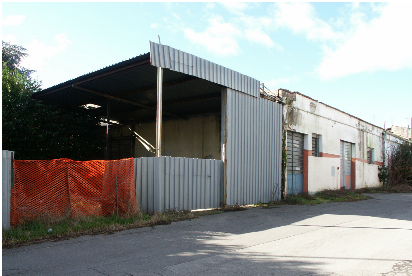
FOTO 1 - Viabilità interna da via delle Fonti
