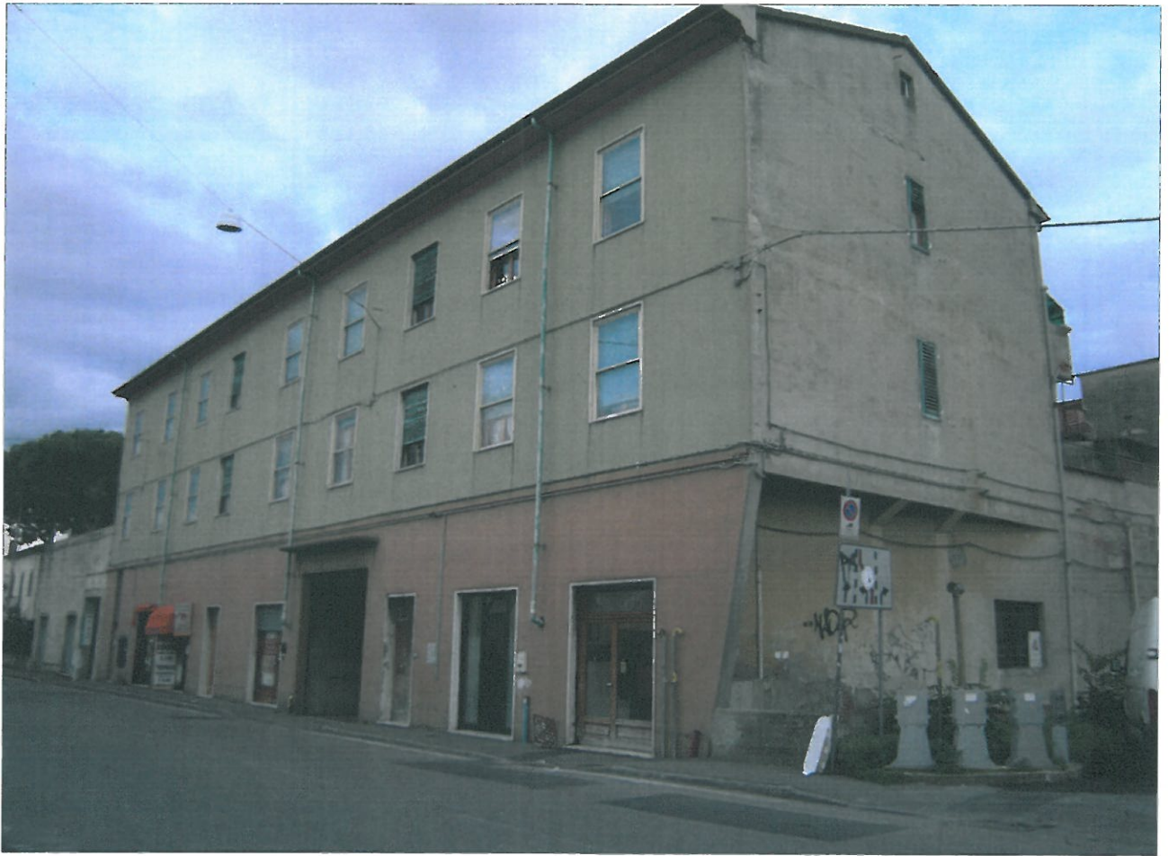
FOTO 1 - Veduta d'insieme con puntamento verso SE
