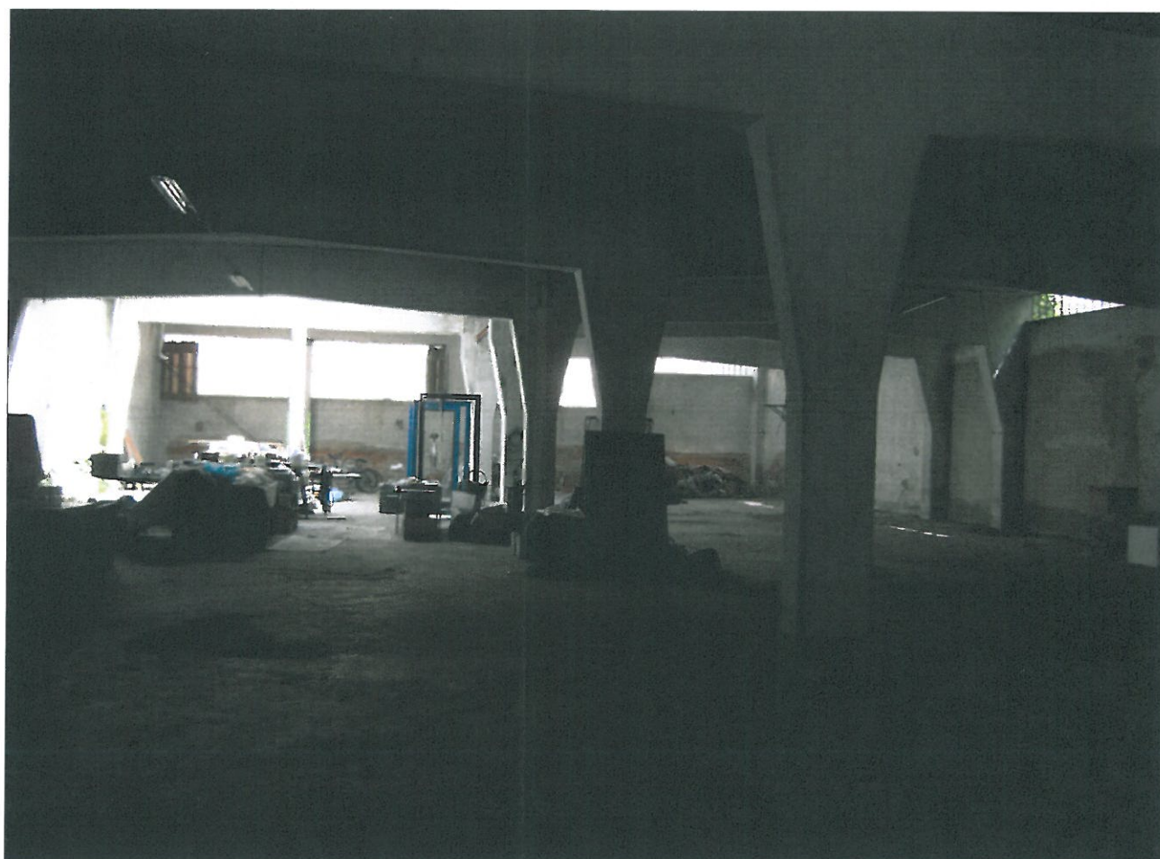
FOTO 4-5 - Veduta d'insieme interna del locale denominato B1
