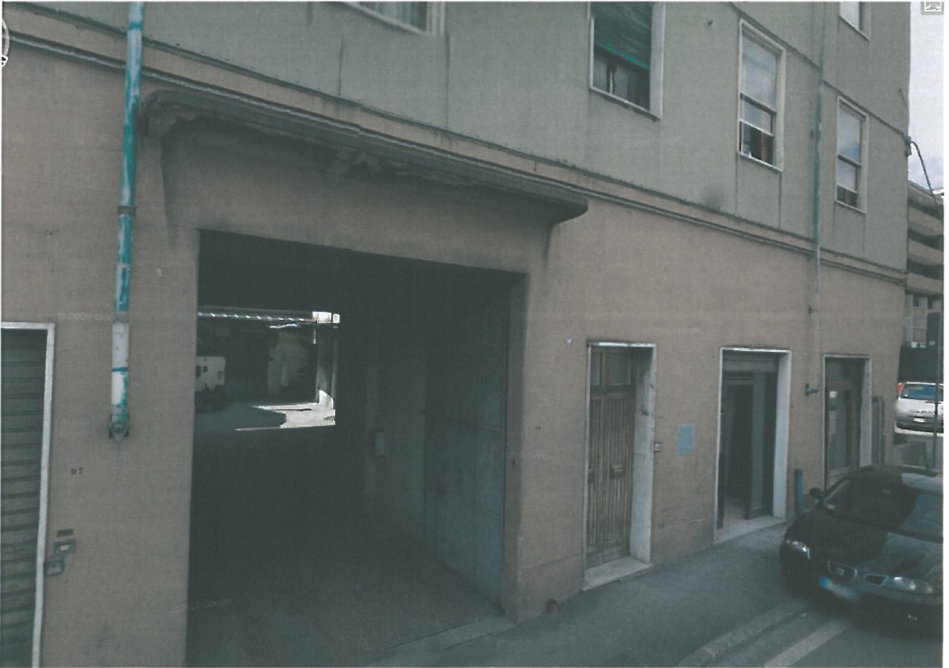
Foto 20 – Particolare ingresso “galleria”
