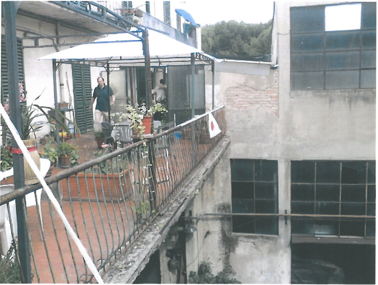
Foto 27 – Particolare terrazzi interni
