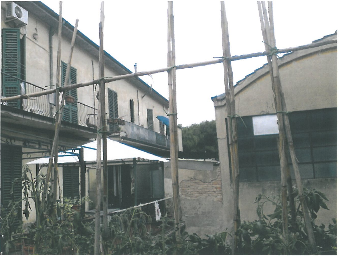
Foto 26 – Particolare terrazzi interni
