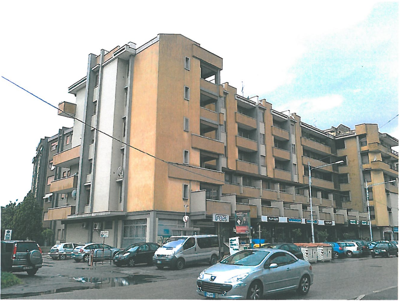
Foto 16 – Condominio limitrofo su via M. Roncioni
