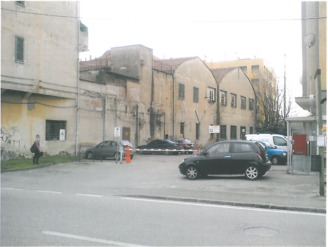
Foto 6 – Vista lato destro fabbrica percorso interno
