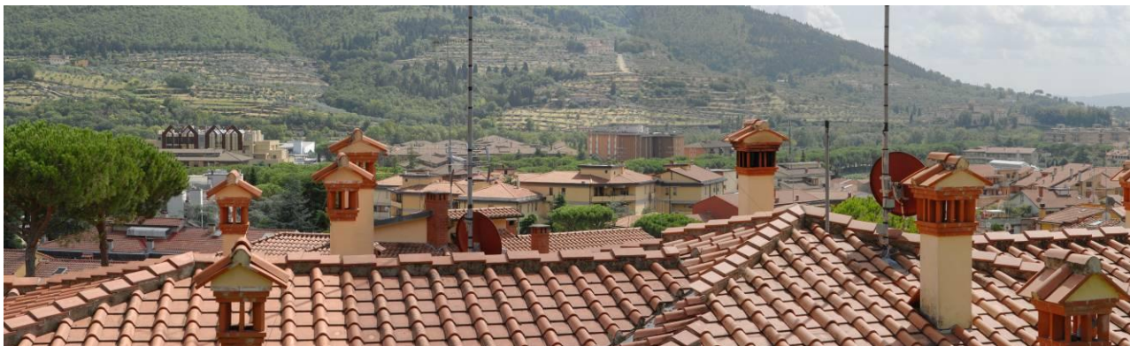
Figura 8 – La vista sull'area interclusa dall'edificato lungo la via Cecconi in prossimità di Le Sacca
