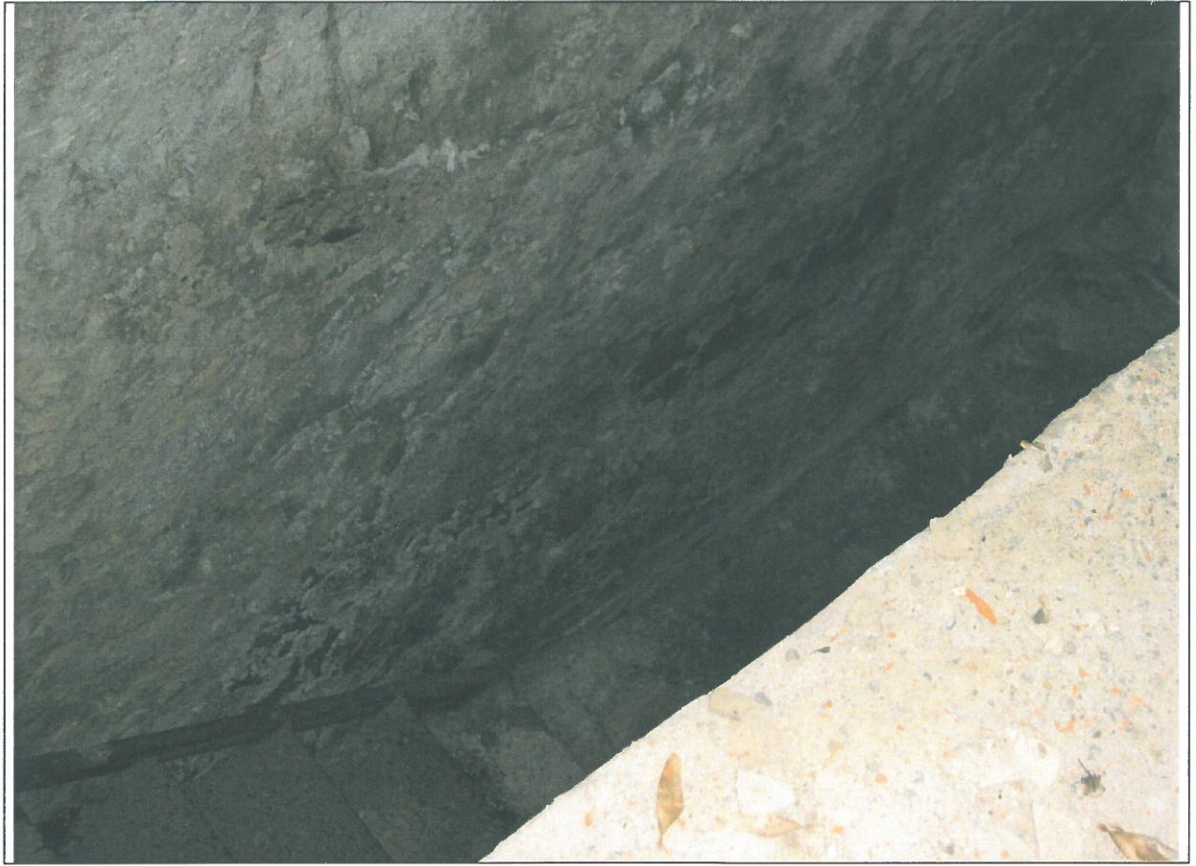
Accesso INTERRATO e base CINTA MURARIA
