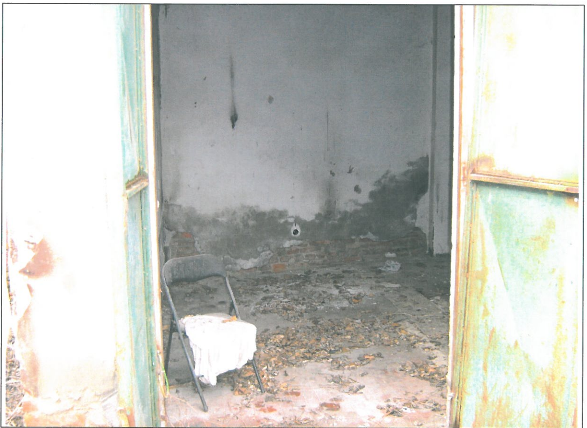
Accesso e interno DEPOSITO
