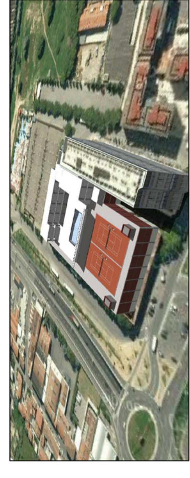
Vista lato OVEST del Fabbricato Oggetto di DEMOLIZIONE
