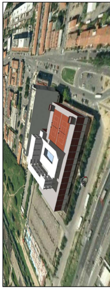
Vista lato NORD del Fabbricato Oggetto di DEMOLIZIONE
