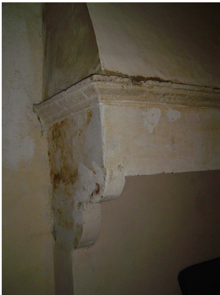
6. Cucina – particolare cappa camino
