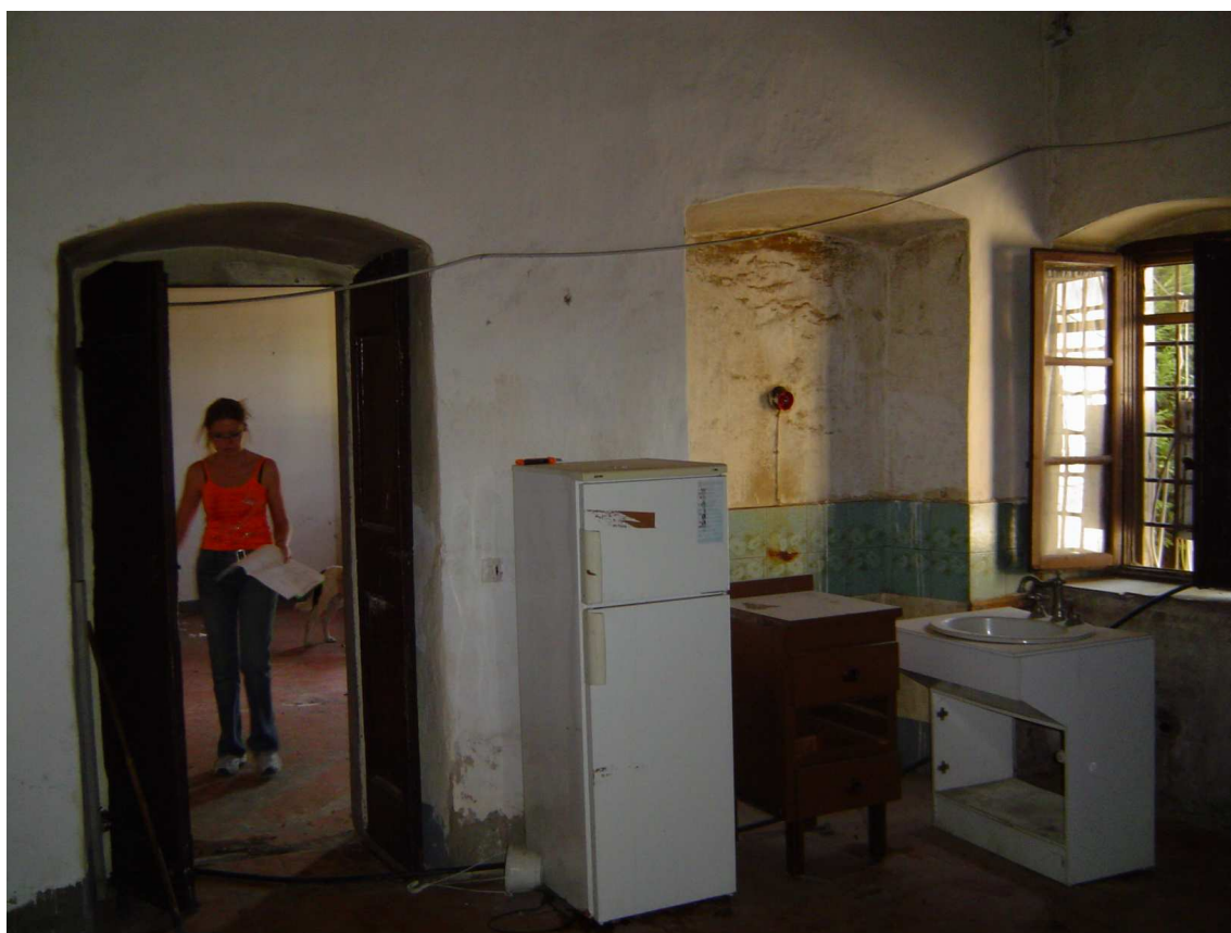
5. Cucina – vista verso l'ingresso
