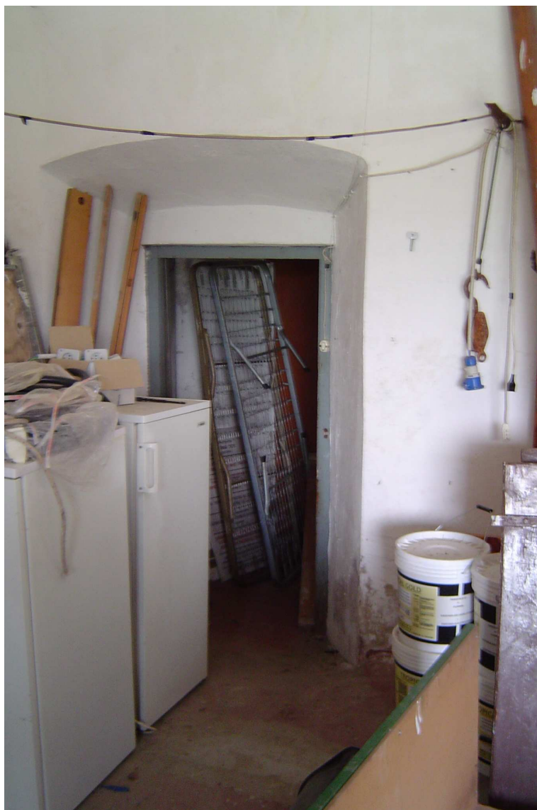
9. Locale lato nord – particolare porta verso il sottoscala
