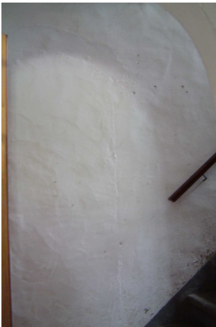
7. Scala – particolare porta tamponata tra la scala e il locale adiacente lato nord
