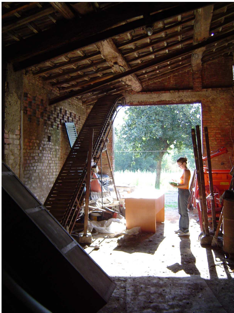
12. Fienile addossato lato nord
