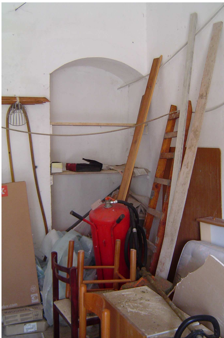
8. Locale lato nord – particolare porta tamponata verso la scala
