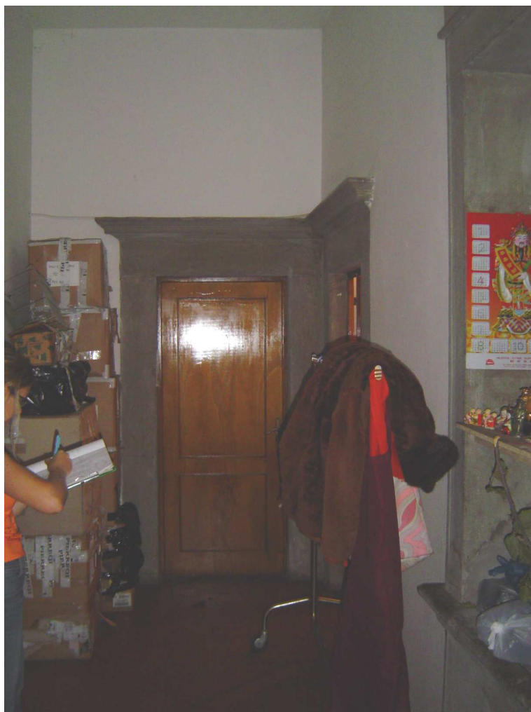
17. Particolare porte corridoio
