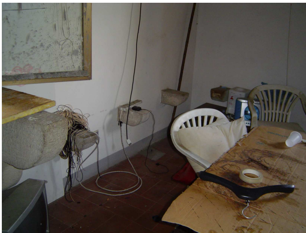
20 – 21. Locale torre – Particolare mensole in pietra
