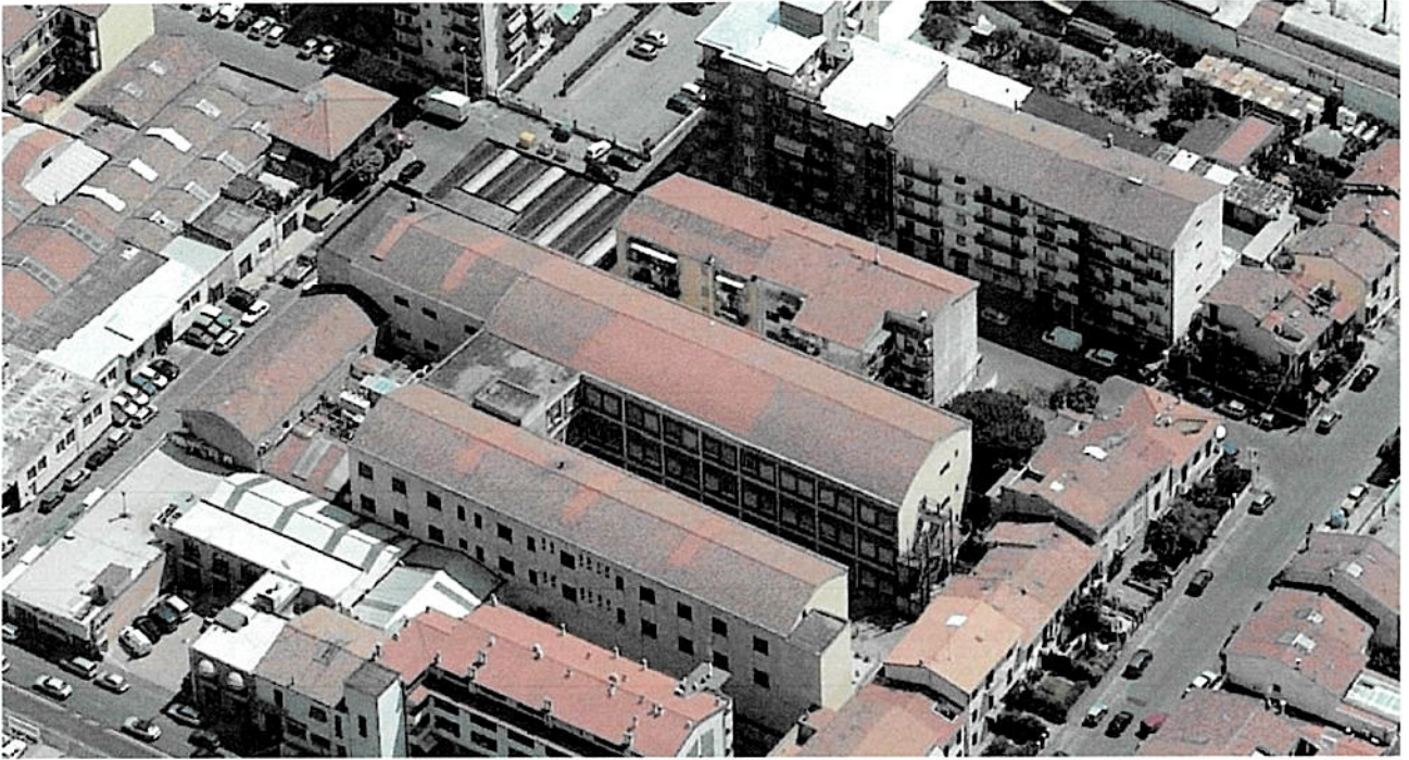
figura 3.a- Immagine dello stato attuale degl'edifici che verranno demoliti
