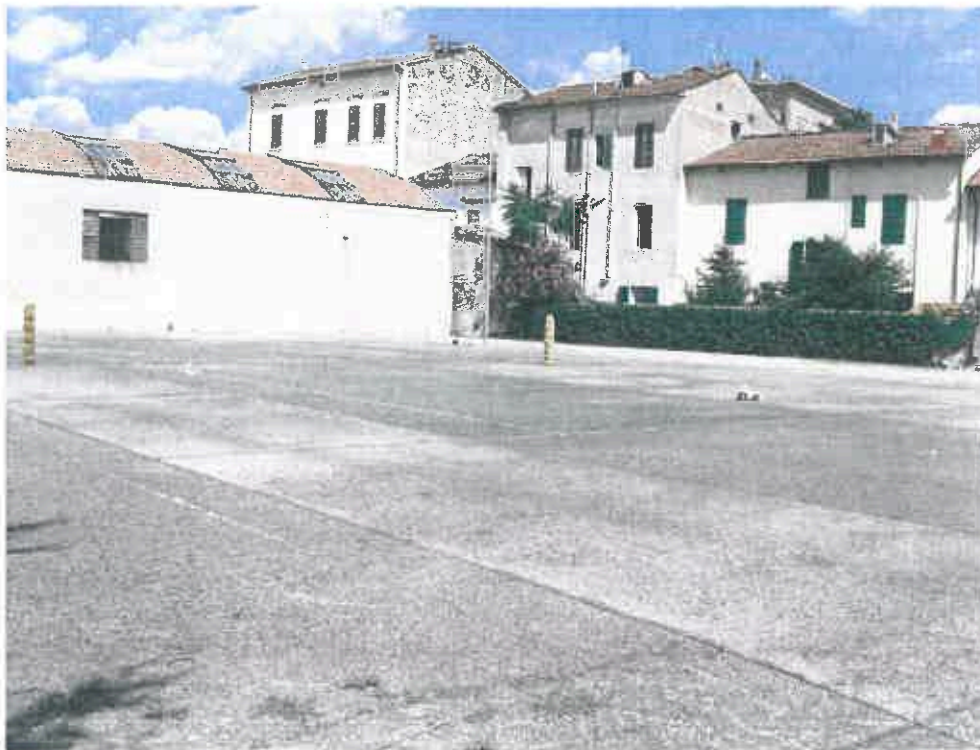
Figura 3: RETRO EDIFICIO EX INDUSTRIALE
