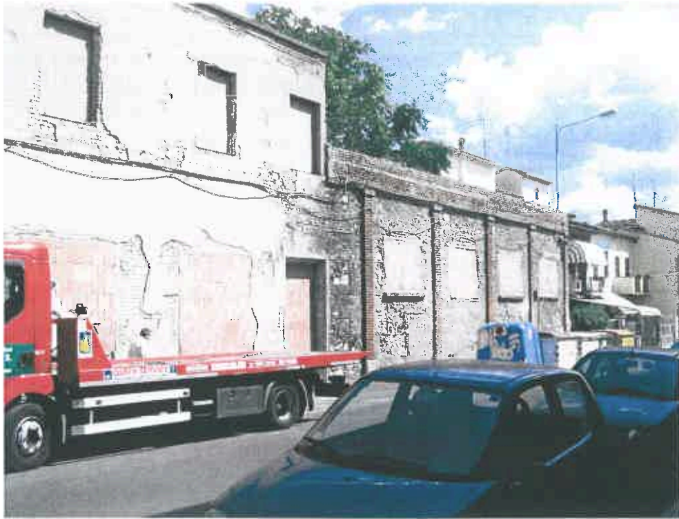
Figura 1: FACCIATA AREA OGGETTO DI INTERVENTO
