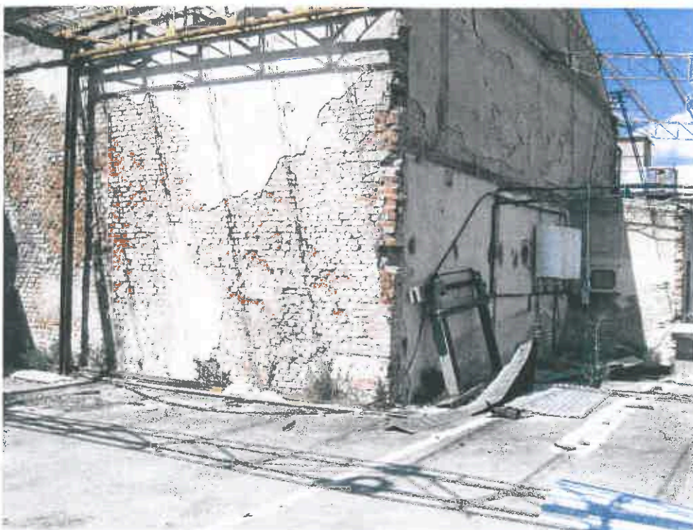
Figura 4: EDIFICIO EX INDUSTRIALE INTERNO ALL'AREA DI RECUPERO
