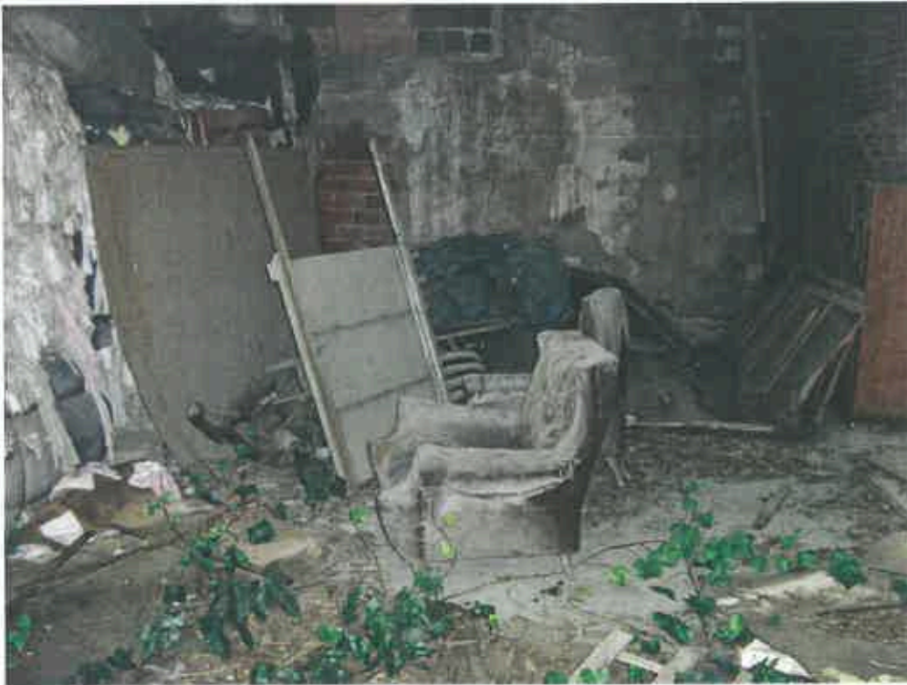
Figura 5: INTERNO DI UNO DEI DEPOSITI
