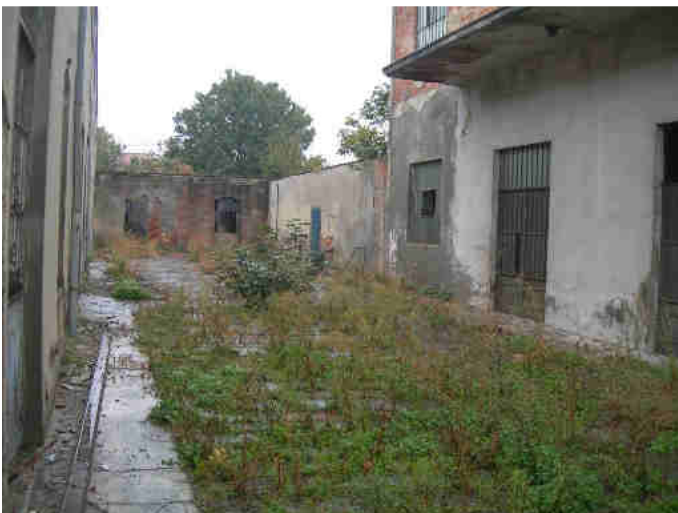
Ripresa da corte interna
