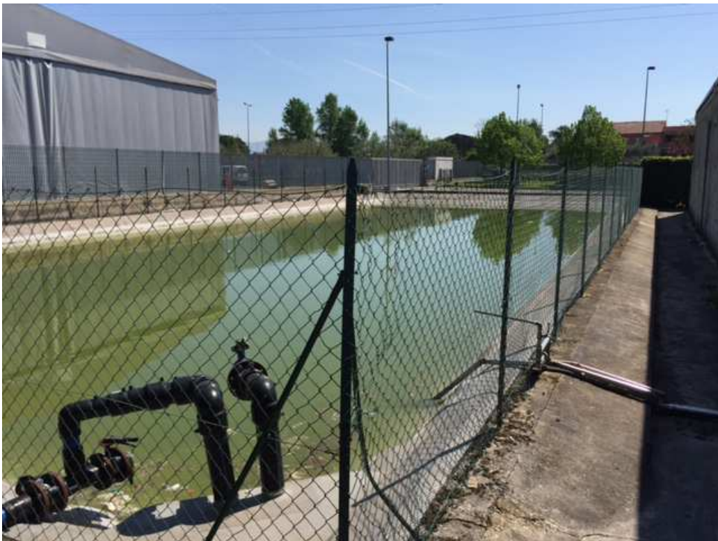
Foto 4- veduta della vasca antincendio esistente
