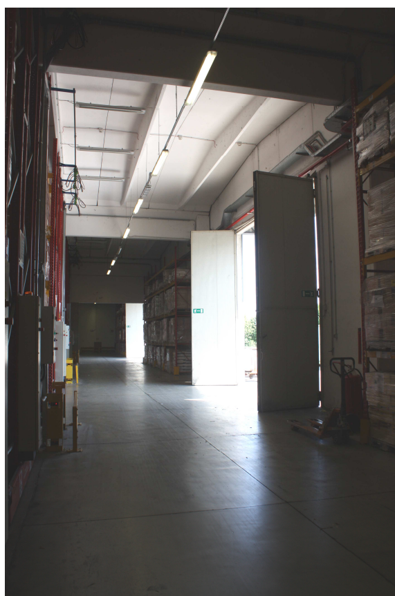
Foto 8 – veduta interna dei locali magazzino al piano terra
