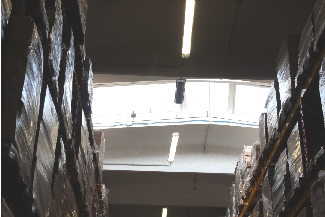
Foto 9 – veduta degli shed esistenti
