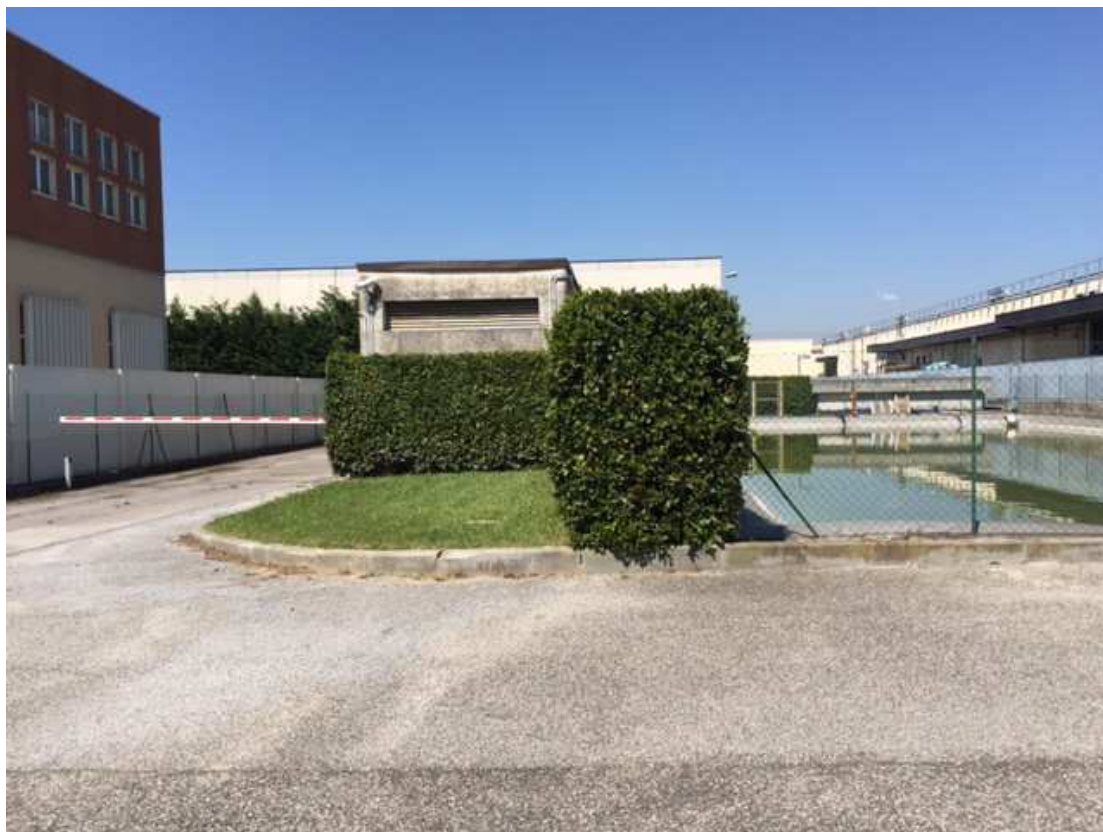
Foto 5- veduta della vasca antincendio esistente
