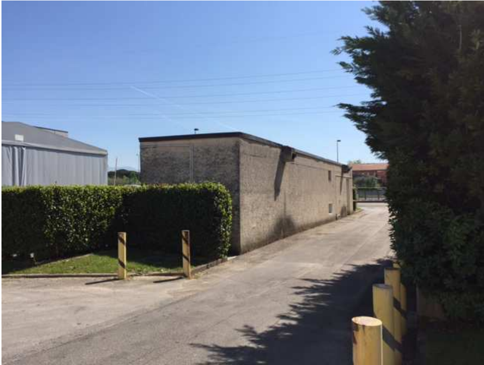
Foto 3- veduta delle aree pertinenziali adiacenti al capannone
