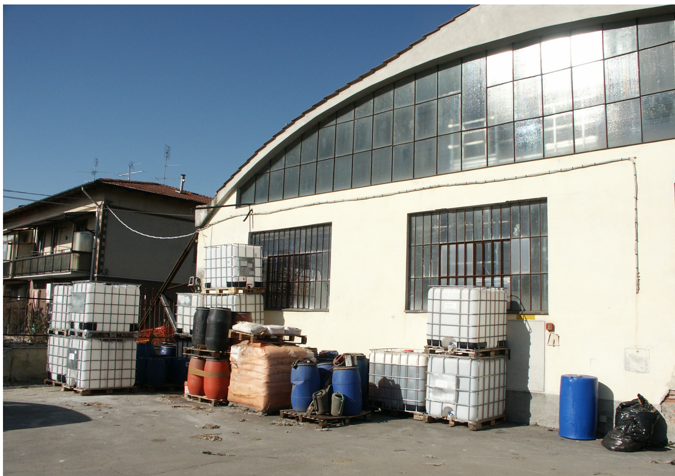
Il fronte principale del fabbricato
