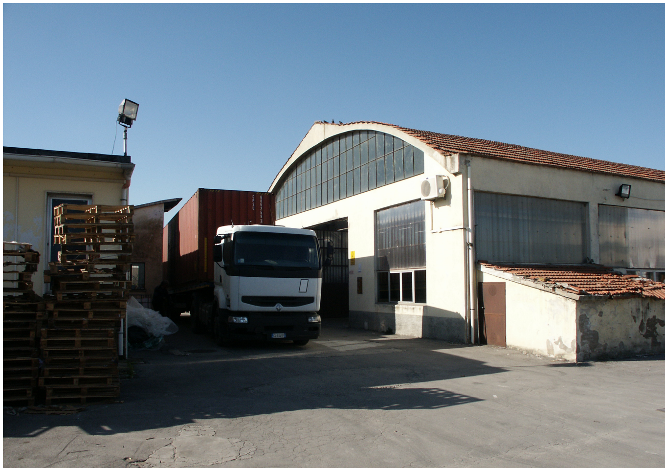
FOTO 3 - Il piazzale della fabbrica
