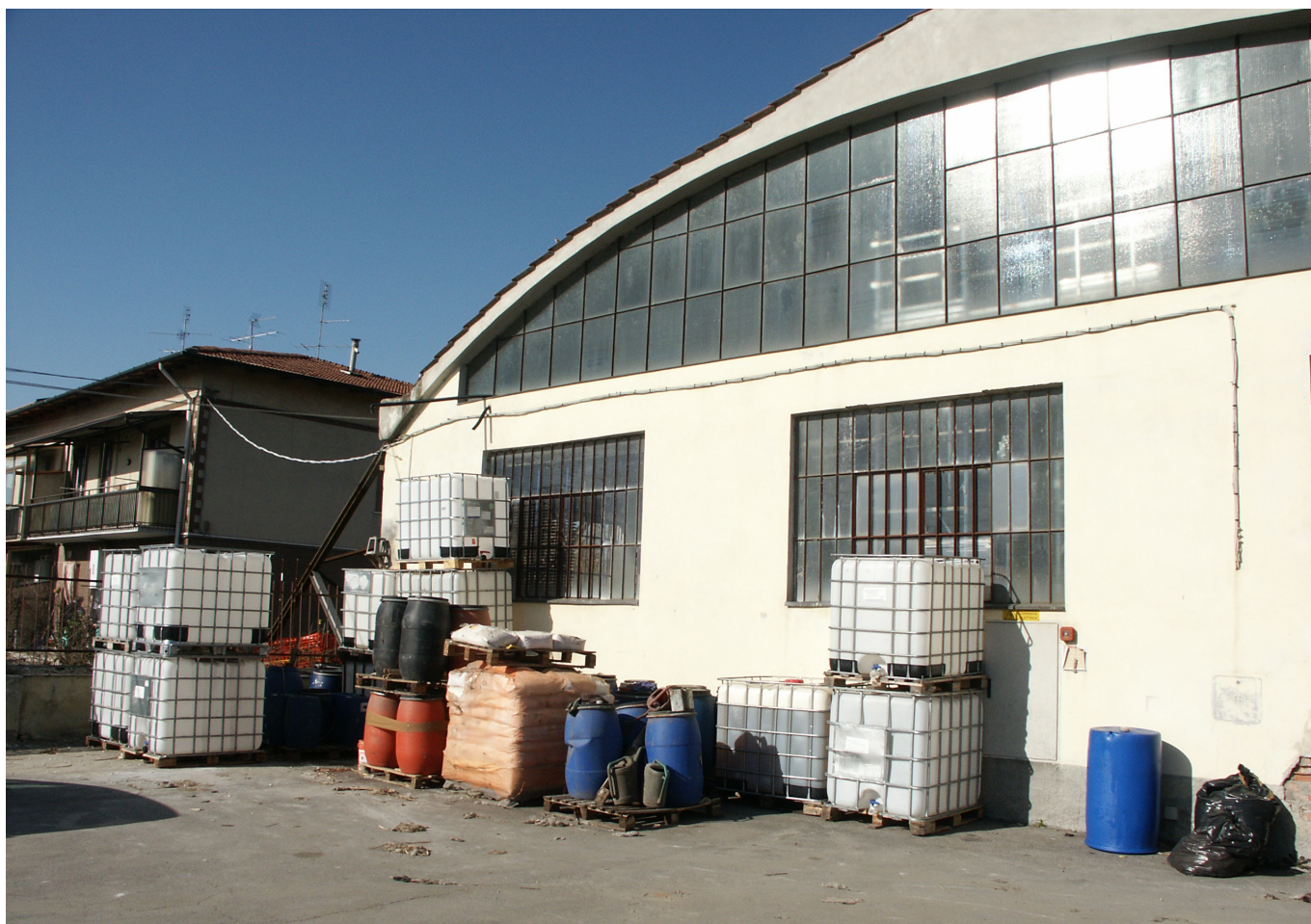
FOTO 4 - Il fronte principale dell'edificio
