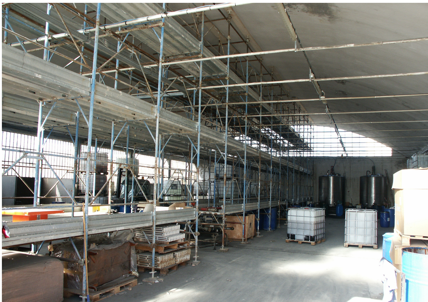
FOTO 8 - Vista interna dell'edificio
