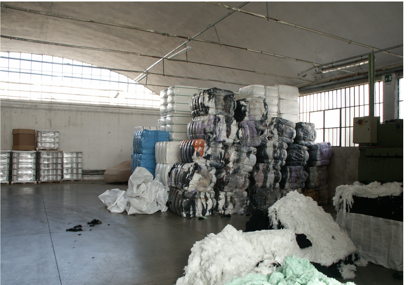
FOTO 10 - Vista interna dell'edificio
