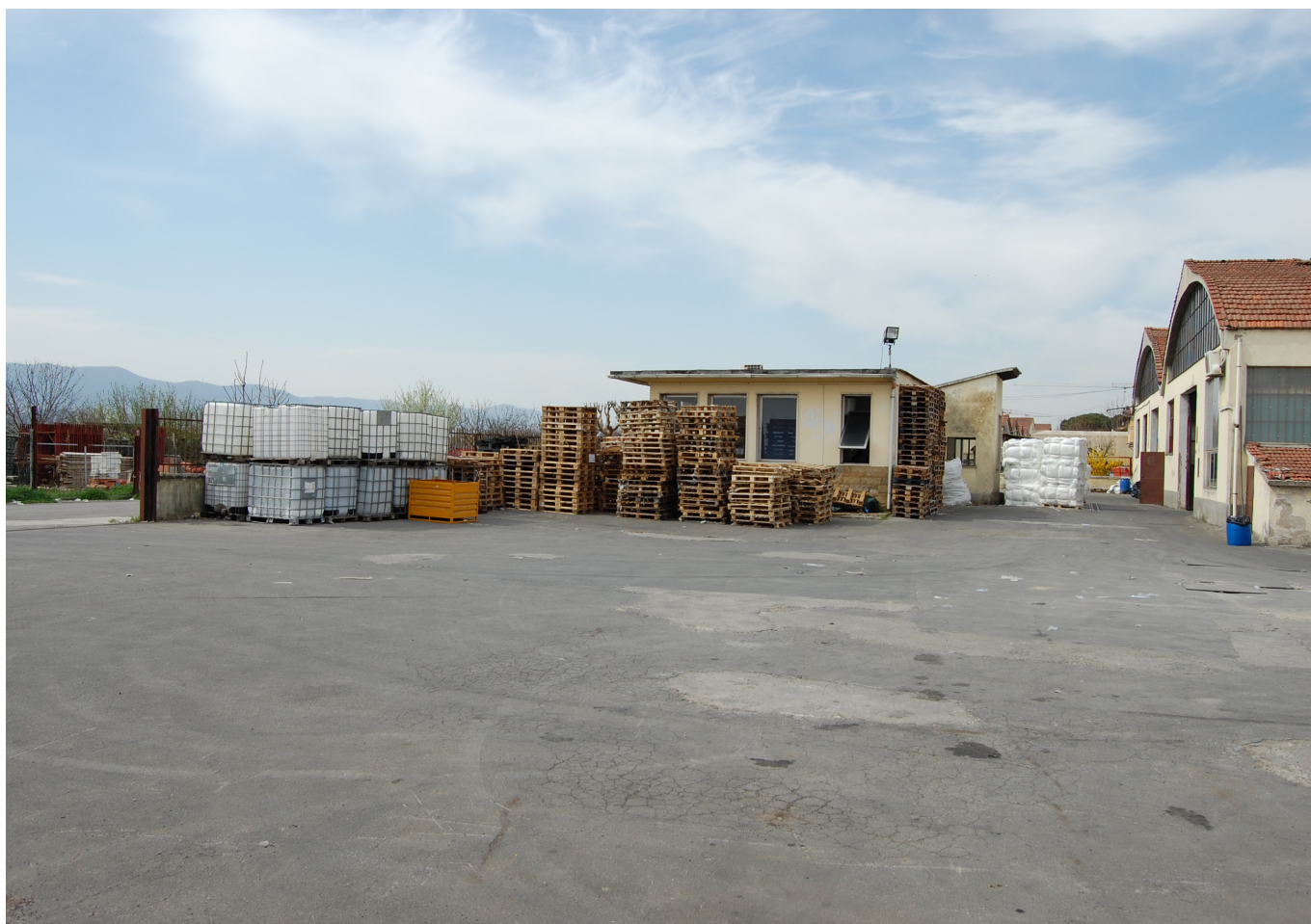
FOTO 2 - Il piazzale della fabbrica
