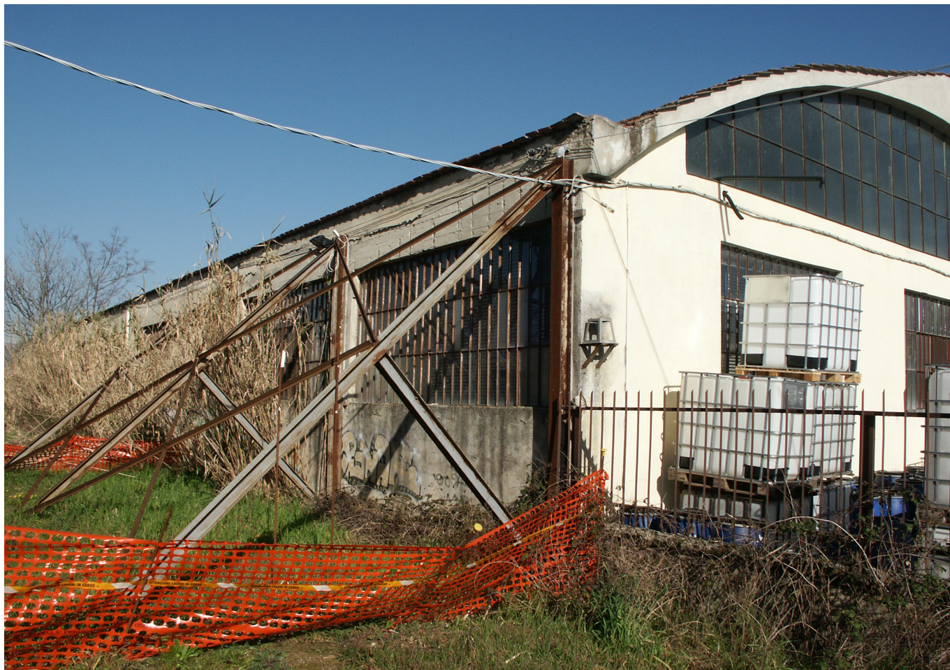
FOTO 5 - Vista verso est dell'edificio
