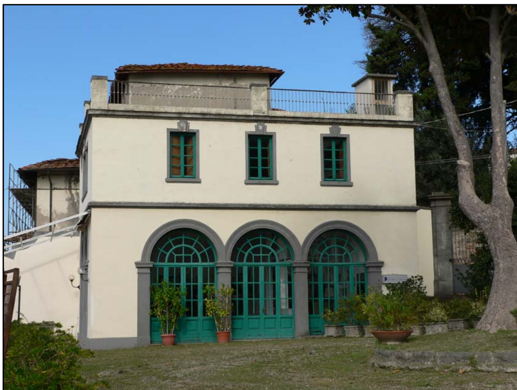
FOTO N.9 La limonaia, struttura realizzata durante i rifacimenti della prima metà del Novecento
