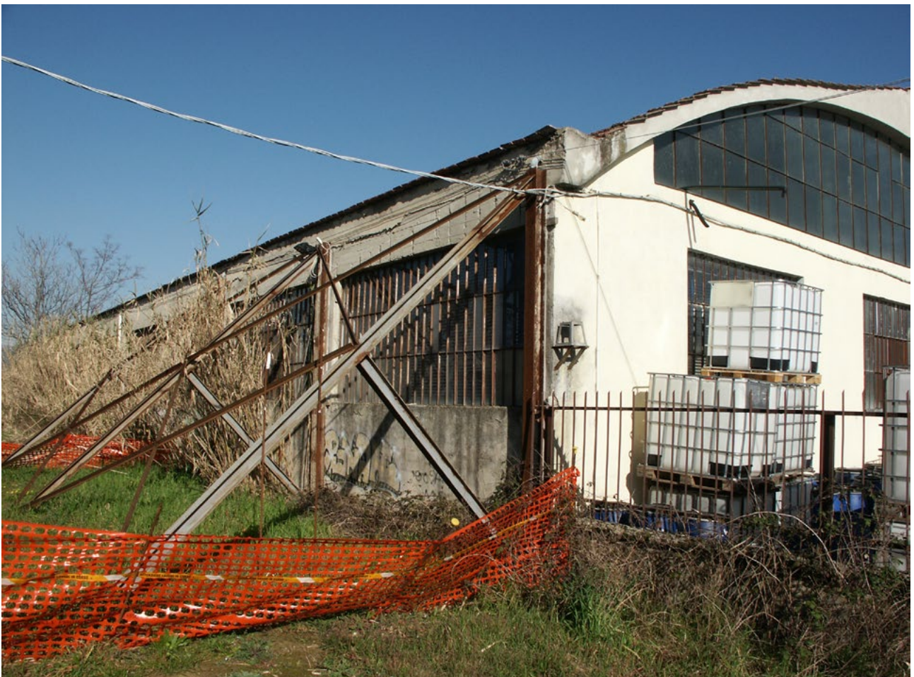
Puntellamento della parete ovest del fabbricato in prossimità del dissesto strutturale
