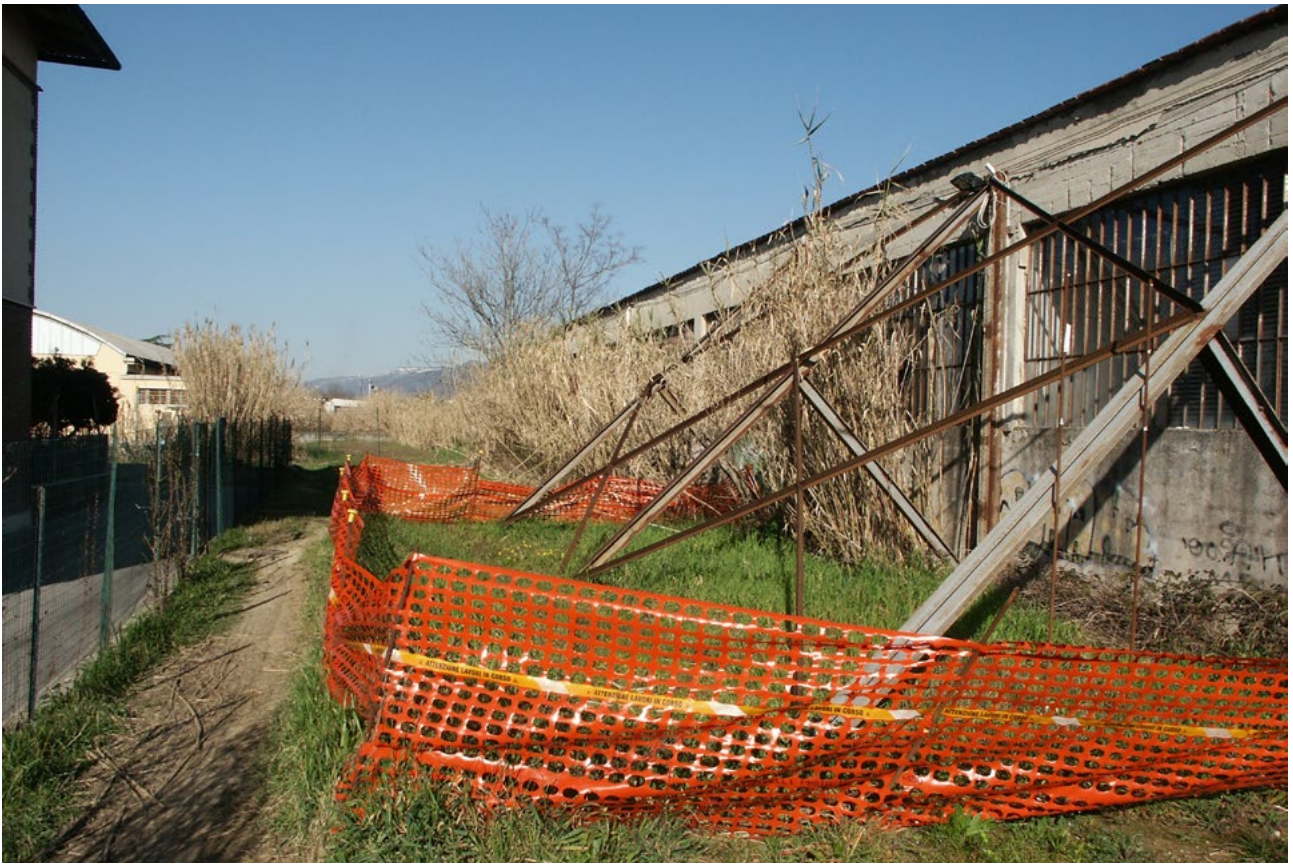
Puntellamento della parete ovest del fabbricato e tratto intubato della gora del Palasaccio
