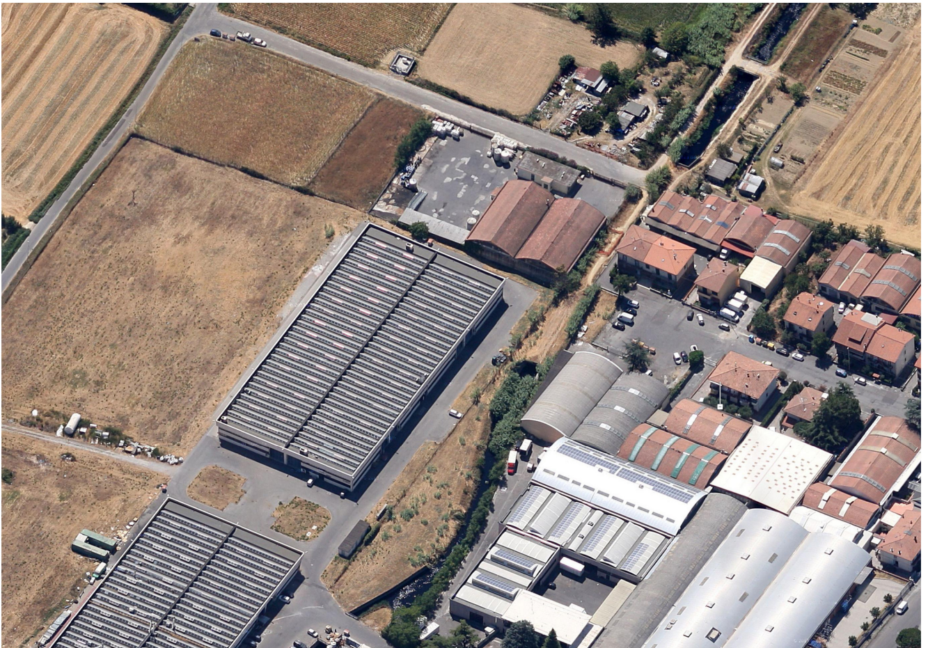
Vista aerea da nord dell'area industriale
