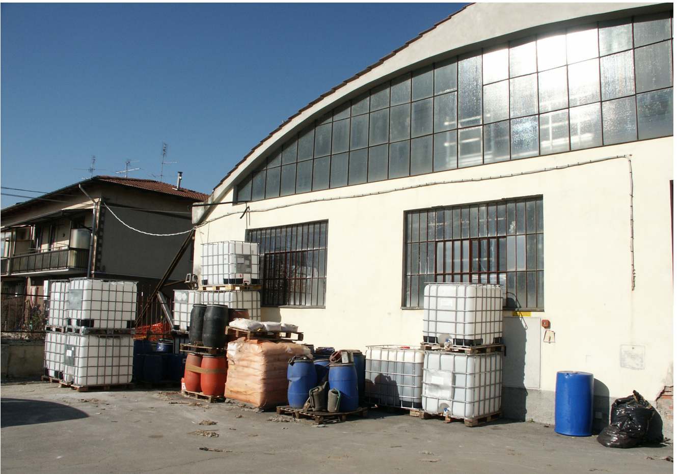
Il fronte principale del fabbricato
