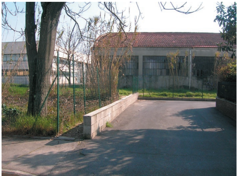
3. Attraversamento della gora intubata da via Marino a via di Castelnuovo.
