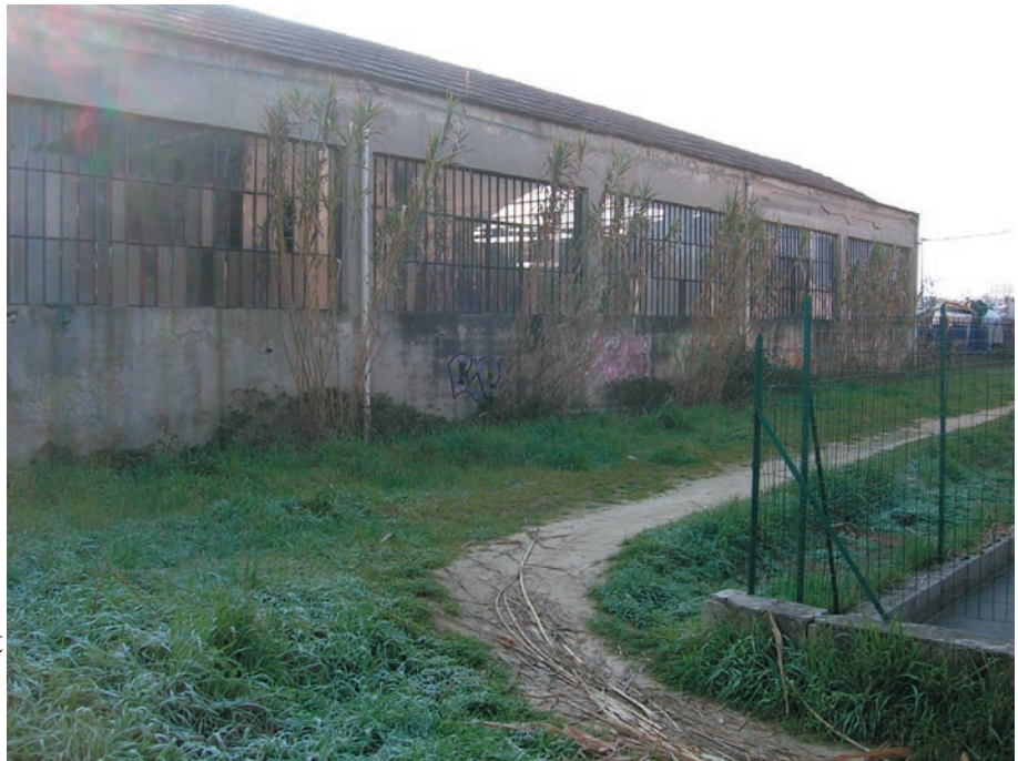
4. Vista del lato nord - ovest della fabbrica IN.TE.CH., lungo la gora intubata
