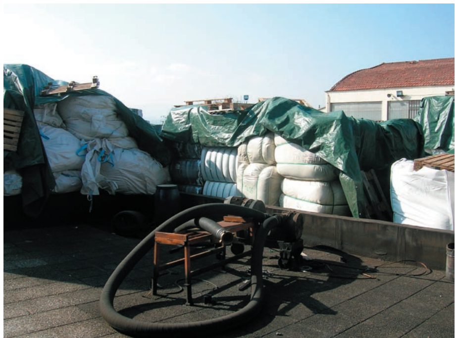
12. Vasca di contenimento dei silos
