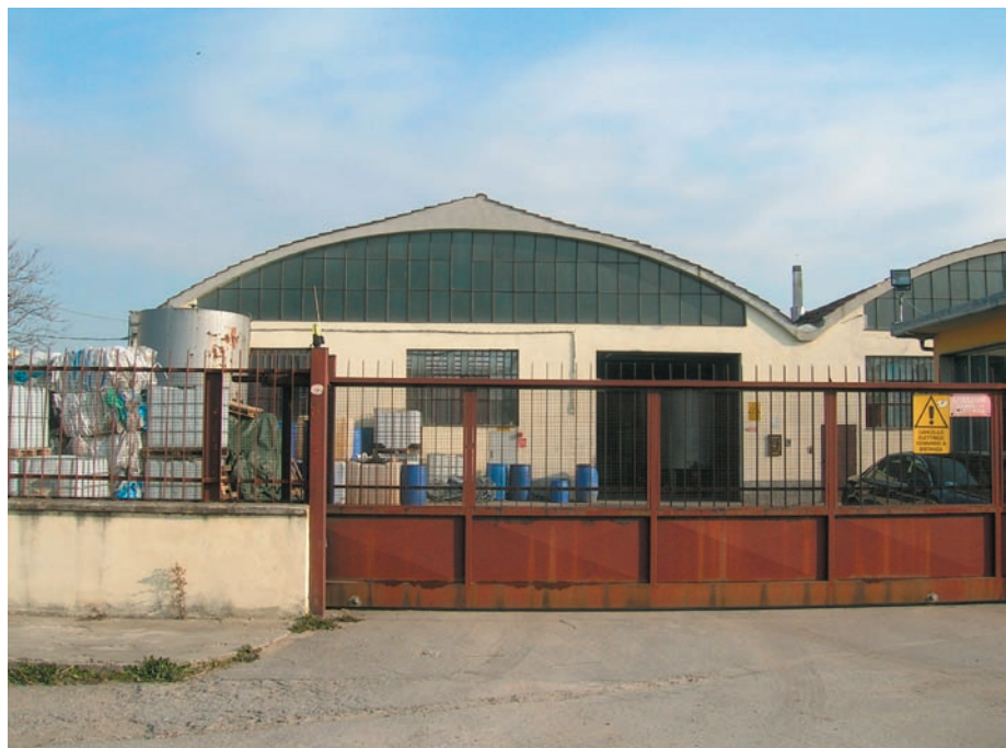
9. Vista del capannone 1
