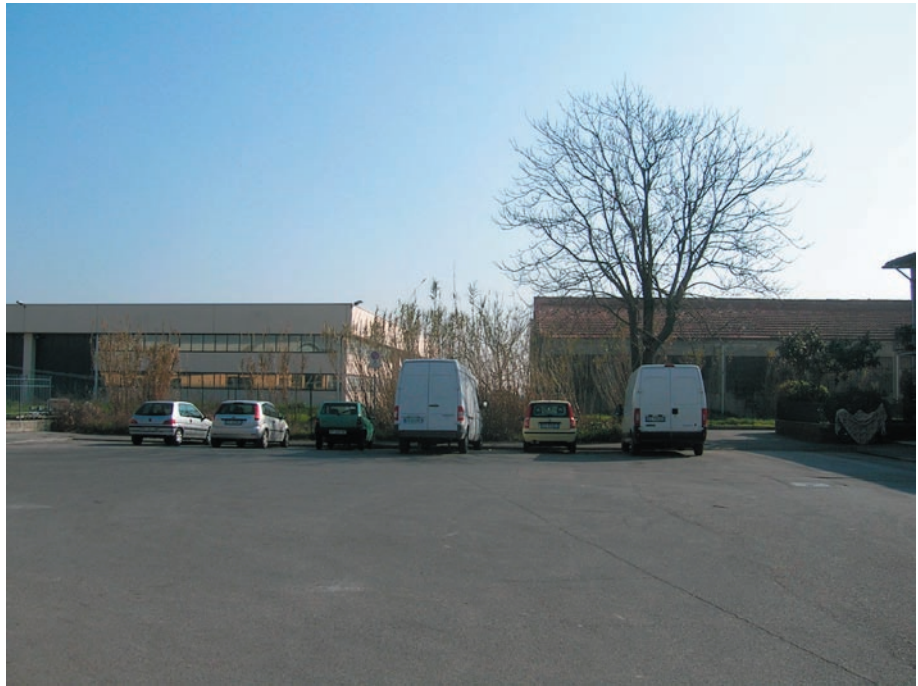
1. La fabbrica IN.TE.CH. e la fabbrica Fedora
