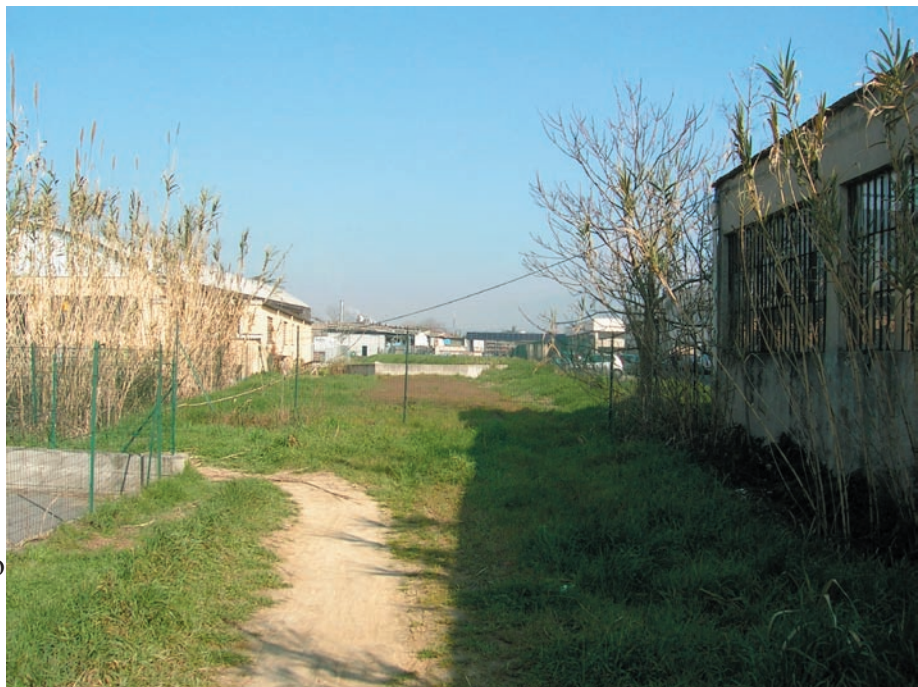
5. Vista verso nord del tratto intubato della gora
