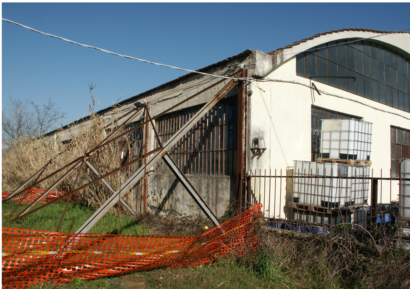
Puntellamento della parete ovest del fabbricato in prossimità del dissesto strutturale
