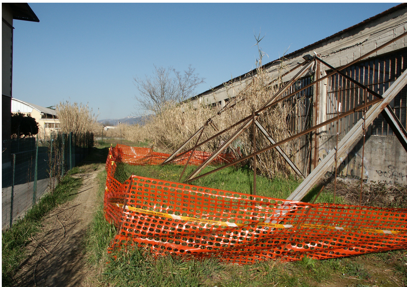
Puntellamento della parete ovest del fabbricato e tratto intubato della gora del Palasaccio
