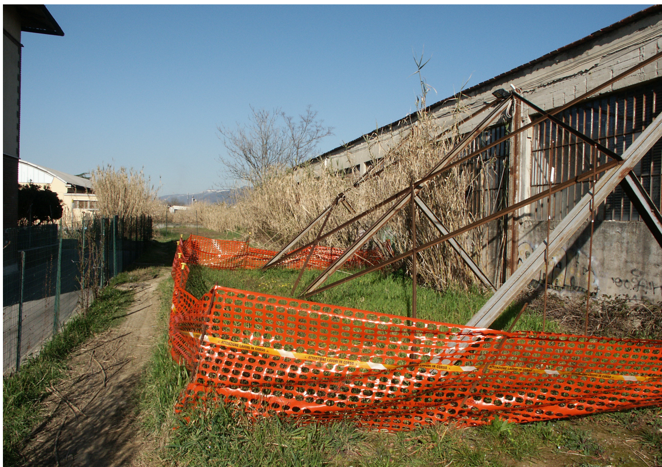
FOTO 6 - Vista dell'edificio e del tratto intubato della gora del Palasaccio
