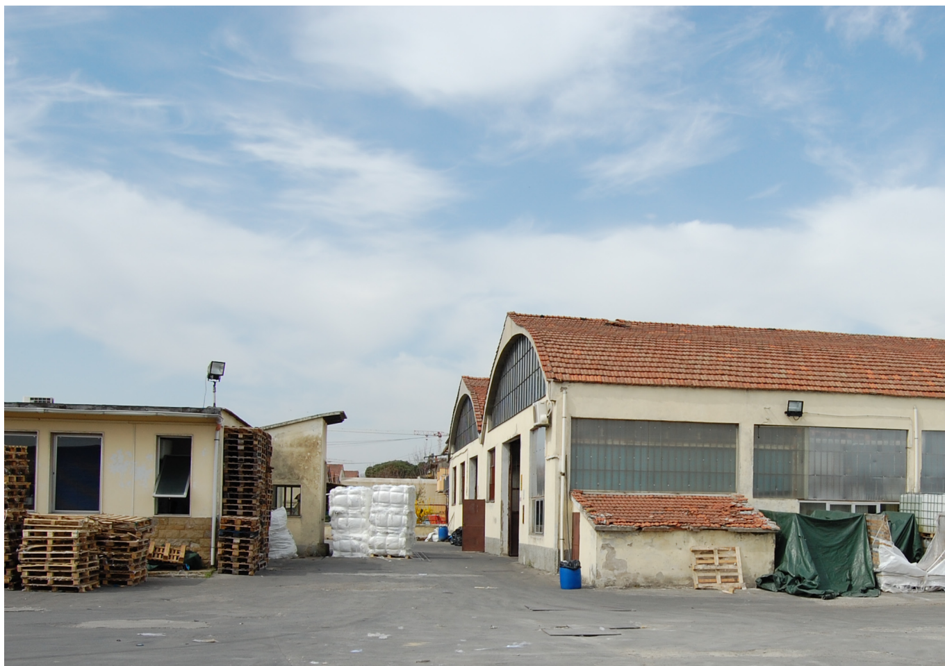
FOTO 1 - Il piazzale della fabbrica
