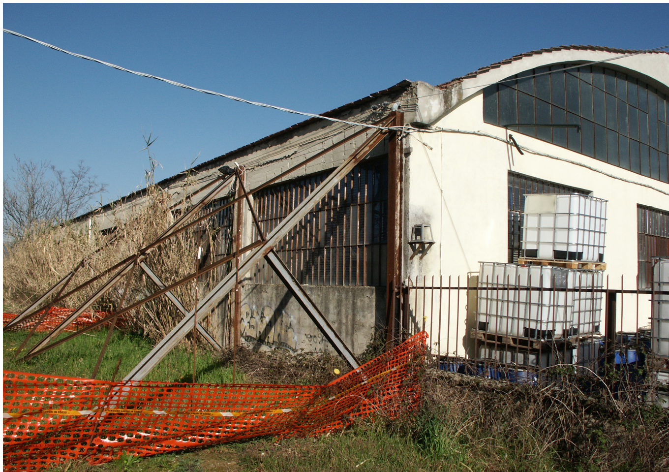
FOTO 5 - Vista verso est dell'edificio
