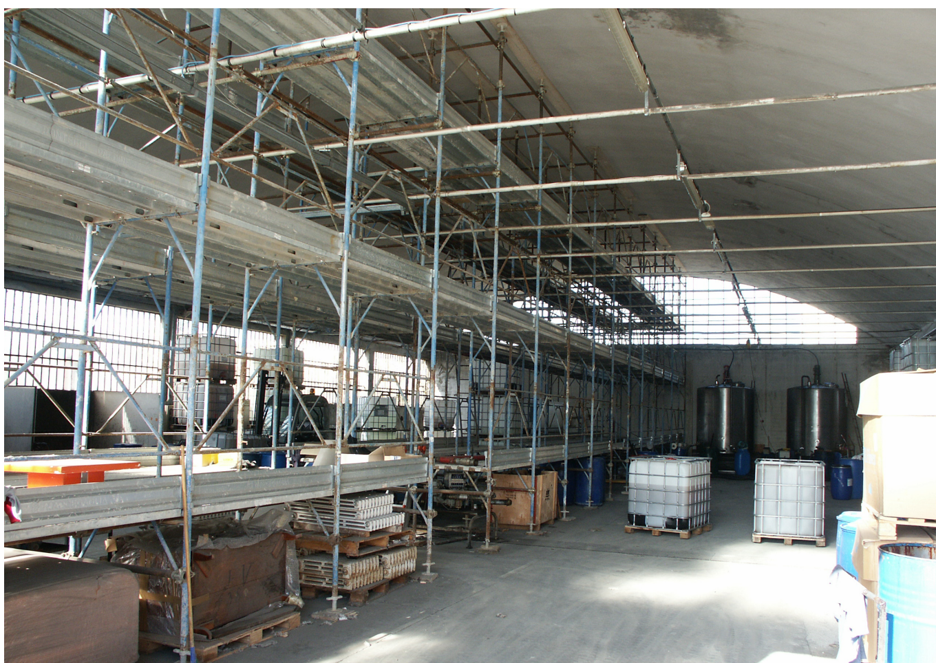
FOTO 8 - Vista interna dell'edificio
