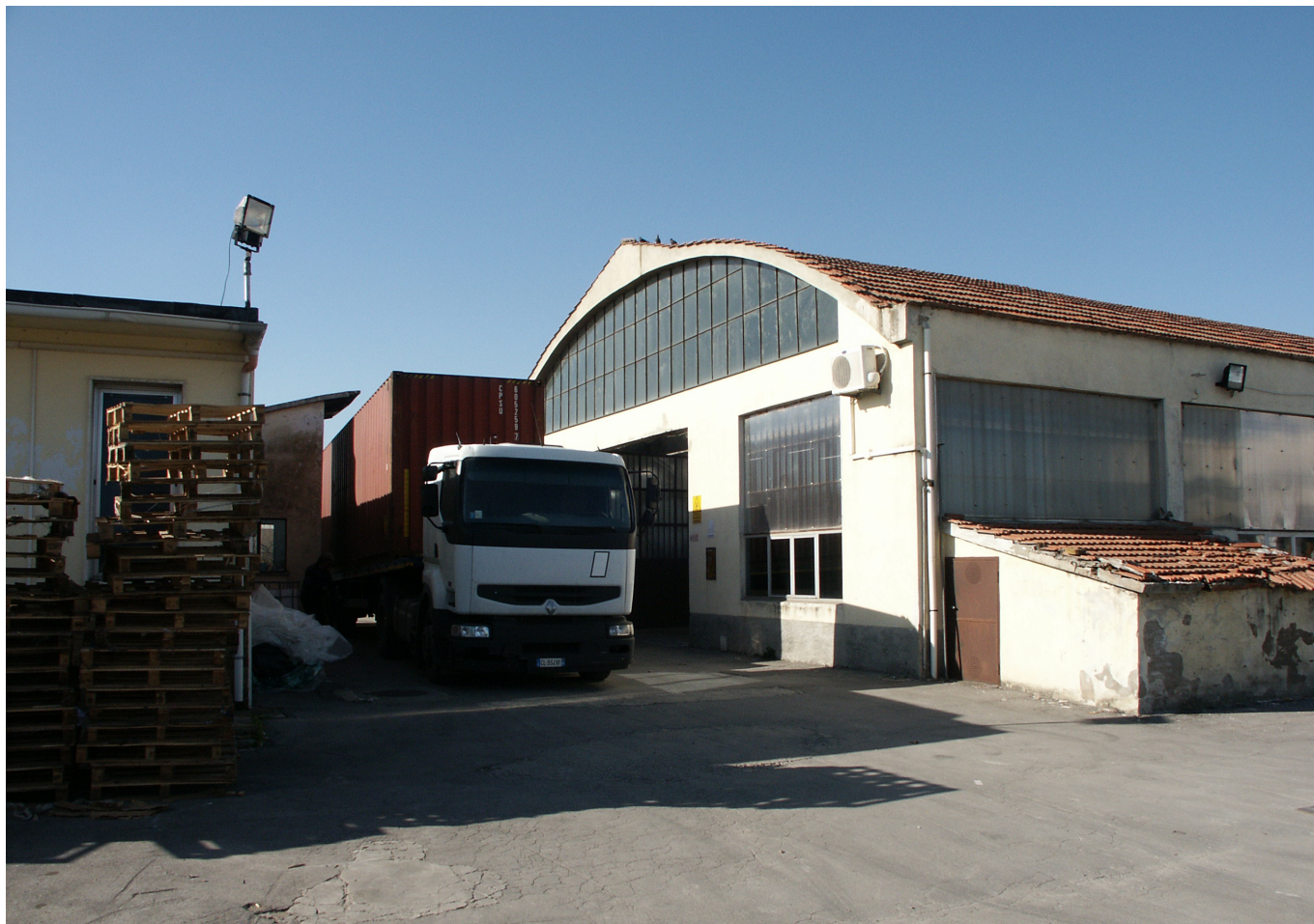
FOTO 3 - Il piazzale della fabbrica
